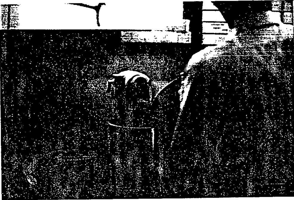
ภาพประกอบ 21 การเทวัสดุลงอย่างผสมเพื่อทำปูนฉาบ
