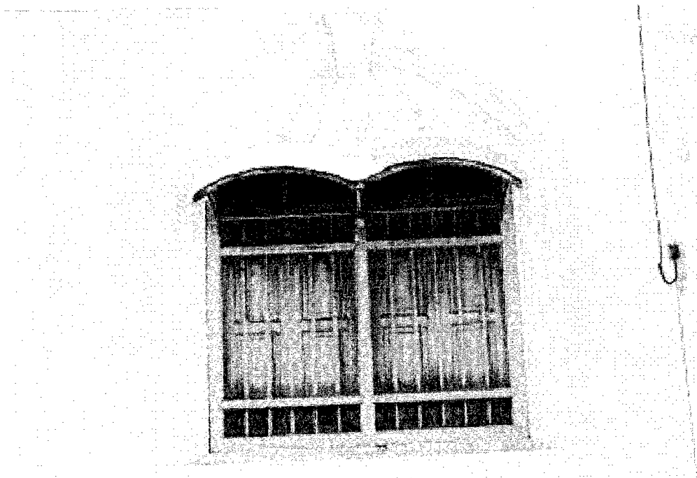
ภาพซุ้มหน้าต่างแบบโค้งเตี้ย สถาปัตยกรรมที่รับมาจากยุโรป (บ้านคุณสงวน ลิ้มปานนท์)
