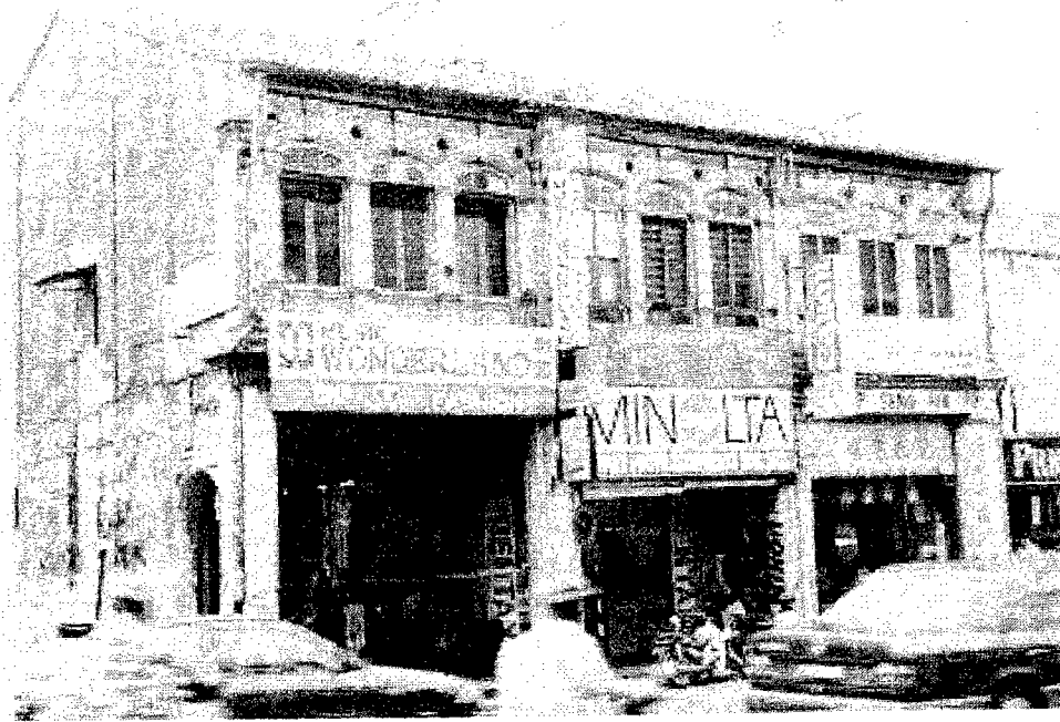
ภาพประกอบ 15 ลักษณะอาคารแบบจีน ข้างล่างเป็นร้านค้า ข้างบนเป็นที่อยู่อาศัย (ปีนัง ประเทศมาเลเซีย)
