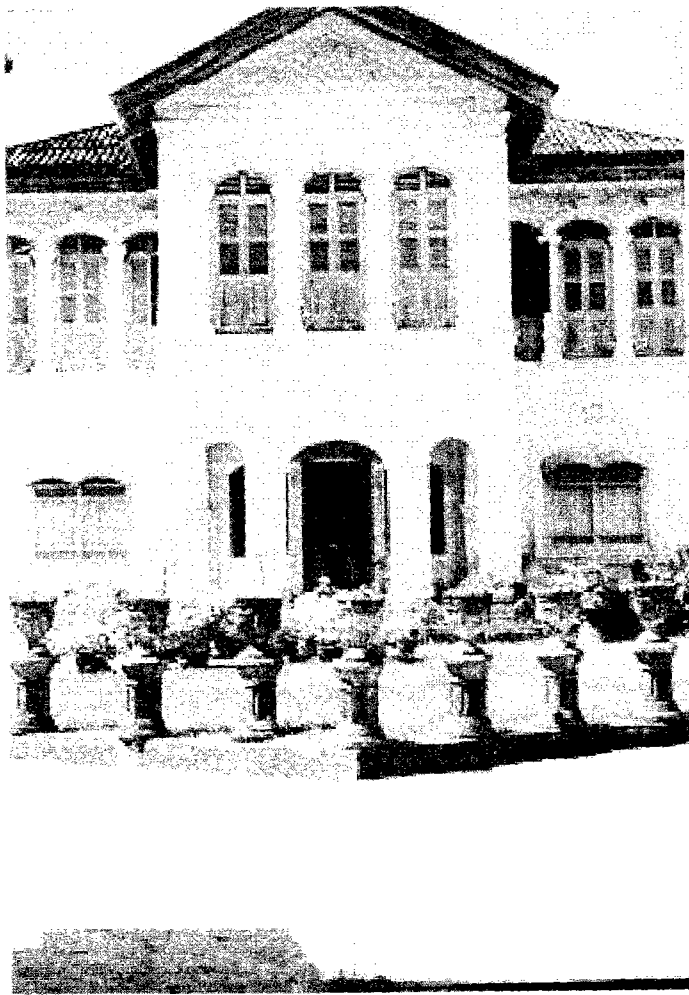
ภาพบ้านคุณสงวน ลิ้มปานนท์ ตั้งอยู่บนถนนเยาวราช อำเภอเมือง จังหวัดภูเก็ต
