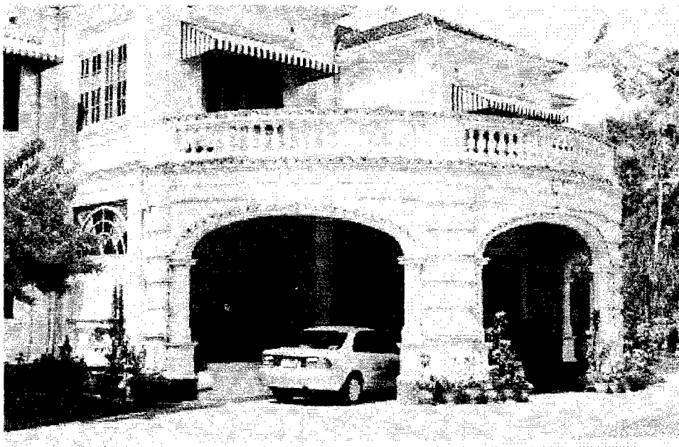
ภาพประกอบ 13 อาคารยุคที่สาม บ้านหลวงอนุภาณุเกิตการ สร้างประมาณ พ.ศ.2480
