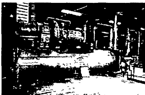
ภาพประกอบ 9 แสดงลักษณะเครื่องทำน้ำเย็นและเครื่องส่งลมเย็น
