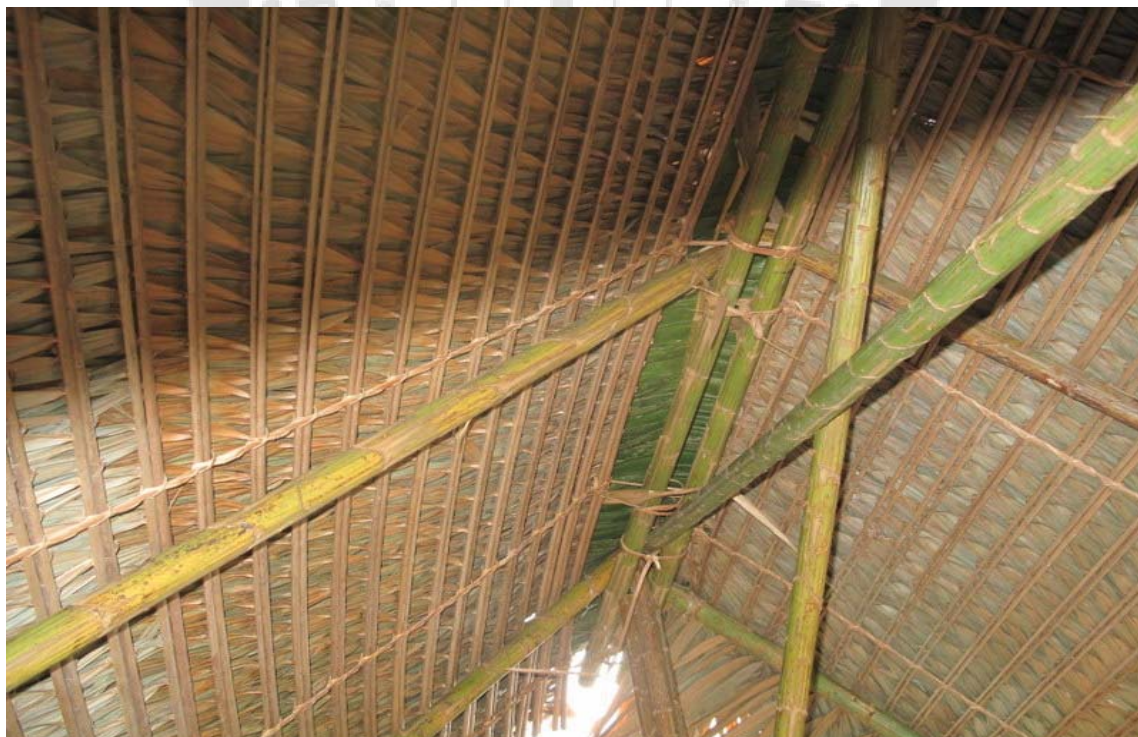
ภาพประกอบ 64 หลังคาบ้านด้านในที่ทำจากไม้ไผ่ ใบโสม และเถาชงโค
