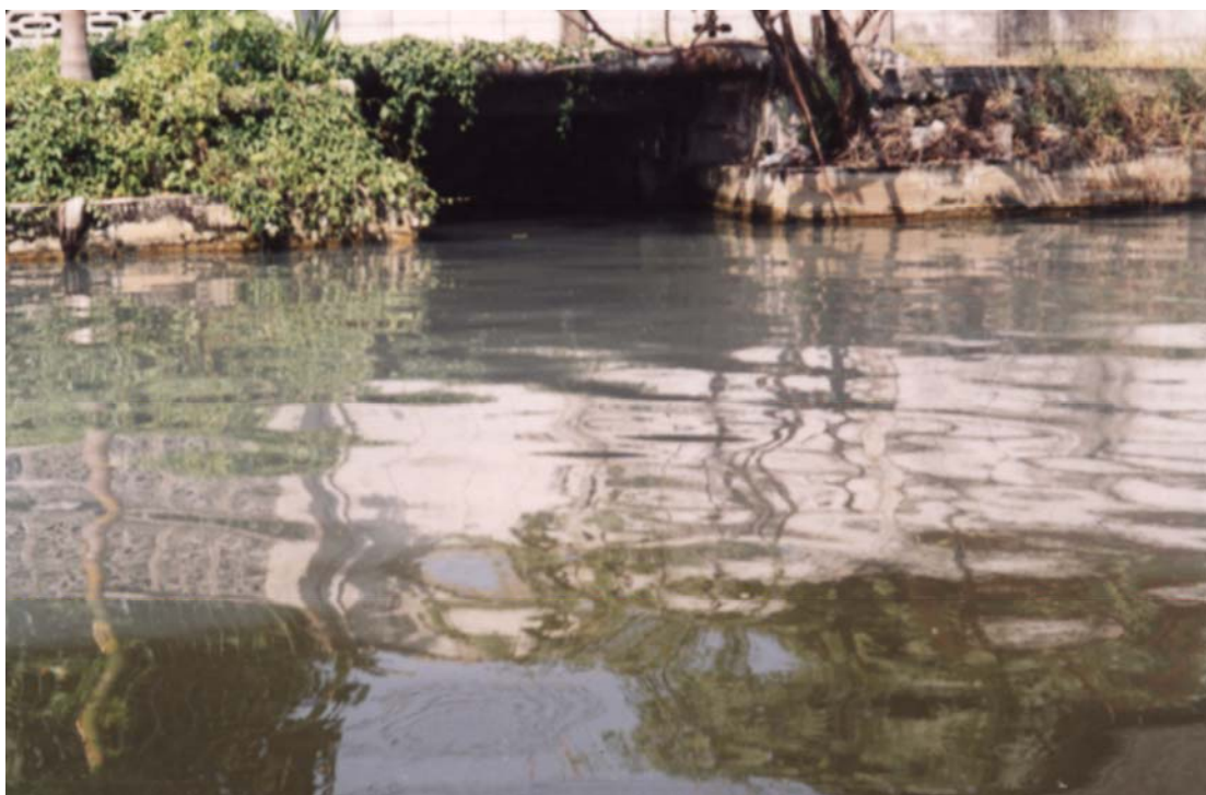
ช่องน้ำทิ้งจากชุมชนที่ตั้งอยู่ริมคลองภาษีเจริญ
