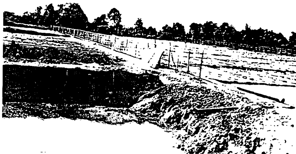
สภาพของบ่อเก็บน้ำเสียในบริเวณลานตากน้ำเกลือ
