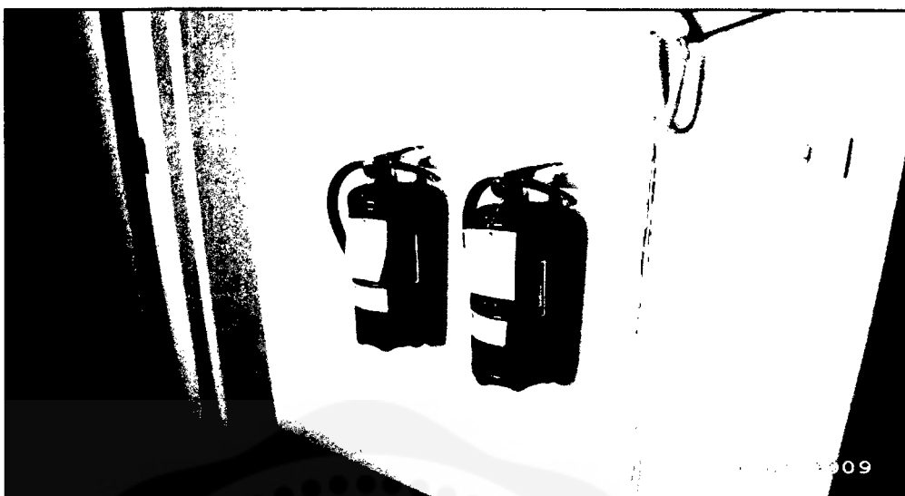
ภาพประกอบ 29 อุปกรณ์ป้องกันอัคคีภัยภายในหอศิลปีสมเด็จพระนางเจ้าสิริกิติ์ พระบรมราชินีนาถ (ถ่ายเมื่อ 6 มีนาคม 2552)
