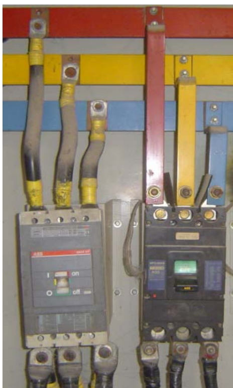
ภาพประกอบ 35 แสดงการติดตั้งเบรกเกอร์ 400A
