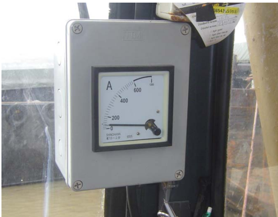
ภาพประกอบ 39 แสดงตำแหน่งติดตั้งแอมป์มิเตอร์ในห้อง Operator
