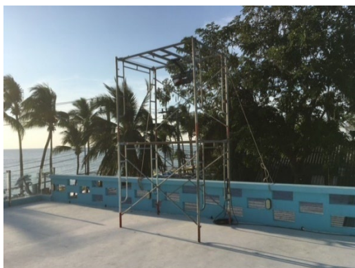
ภาพที่ 5.75 การติดตั้งเครื่องโปรเจคเตอร์ หมายเหตุ. จาก ผู้เขียน
