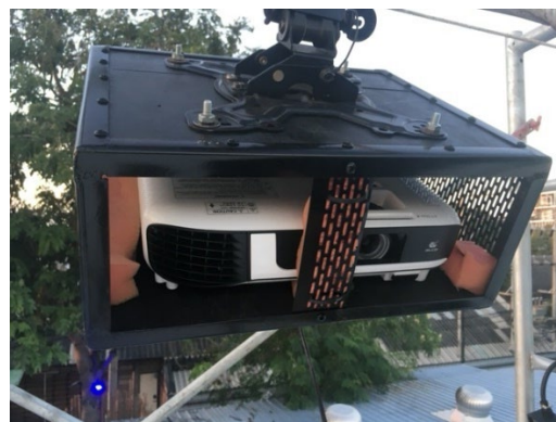
ภาพที่ 5.76 การติดตั้งเครื่องโปรเจคเตอร์
