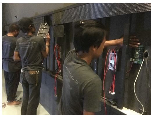
ภาพที่ 5.44 การติดตั้งแผงจอแอลอีดี (led)
