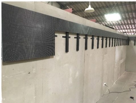
ภาพที่ 5.57 การติดตั้งโครงเหล็ก
