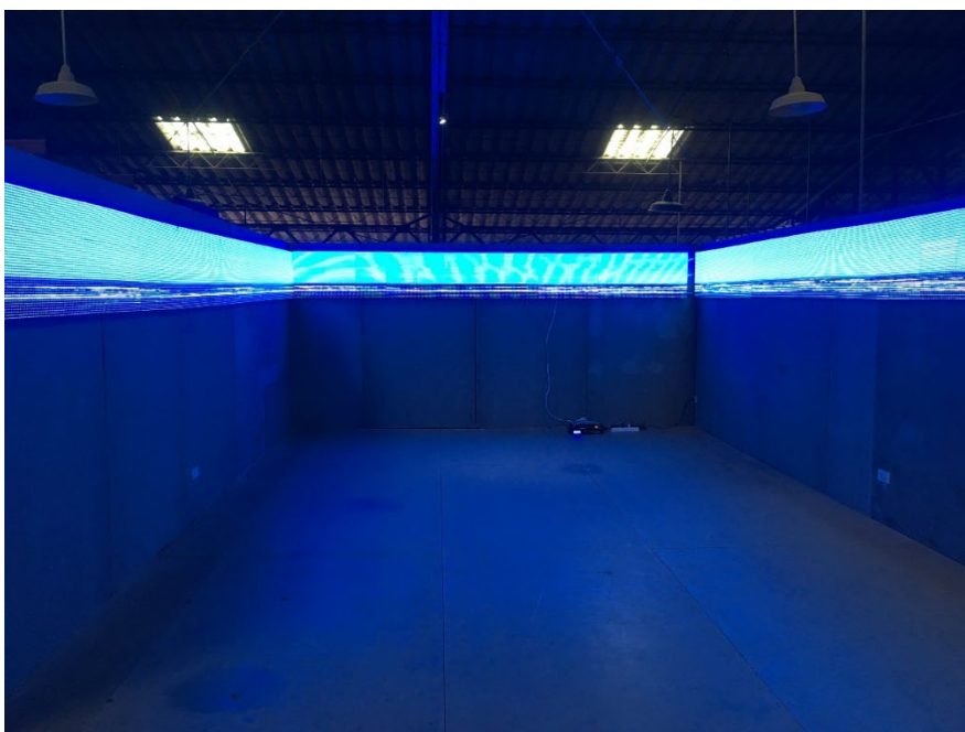
ภาพที่ 5.60 การติดตั้งเสร็จสมบูรณ์
