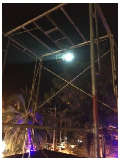
ภาพที่ 5.77 การติดตั้งผลงาน หมายเหตุ. จาก ผู้เขียน
