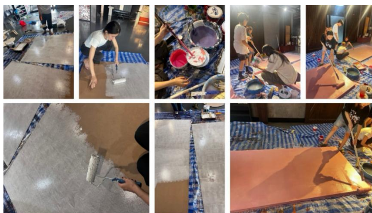
ภาพที่ 3.48 : ภาพการทำสีผนังห้องครัวภายในร้านเสริมสวย
