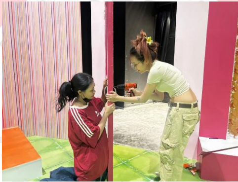
ภาพที่ 3.27 : ภาพการติดตั้งที่จับประตู
