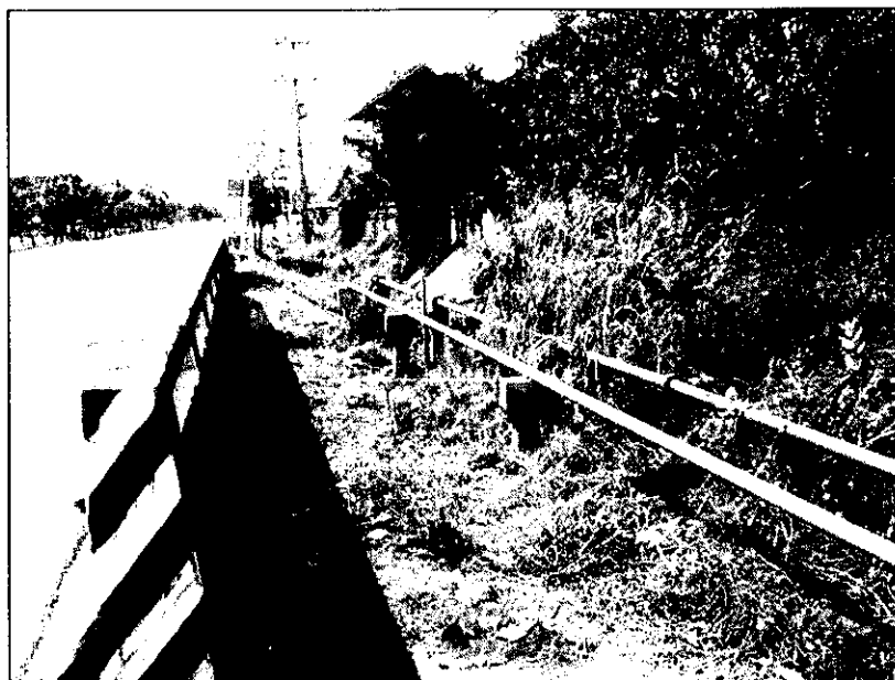
ภาพประกอบ สภาพแวดล้อมของสะพานบนทางหลวงหมายเลข 4 ณ หลักกิโลเมตรที่ 182+943 ทางด้านน้ำเข้า มีการสร้างที่อยู่อาศัยปิดช่องทางระบายน้ำ
