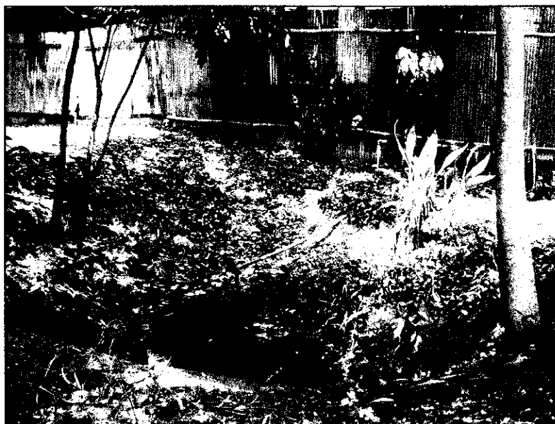
ภาพประกอบ สภาพแวดล้อมของท่อเหลี่ยมบนทางหลวงหมายเลข 3178 ณ หลักกิโลเมตรที่ 8+025 ทางด้านน้ำเข้า และทางด้านน้ำออกมีการสร้างที่อยู่อาศัยปิดช่องทางระบายน้ำ
