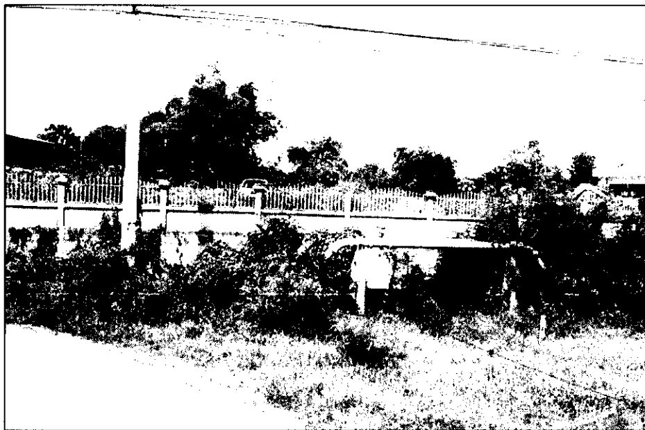
ภาพประกอบ สภาพแวดล้อมของสะพานบนทางหลวงหมายเลข 4 ณ หลักกิโลเมตรที่ 15+706 ทางด้านน้ำออก เป็นทุ่งหญ้าและมีการถมที่ขวางช่องทางระบายน้ำ
