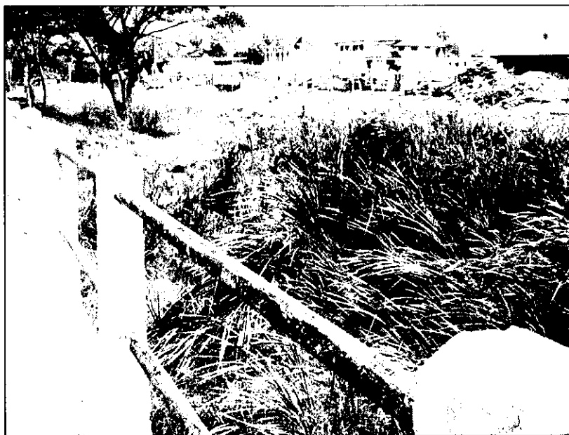
ภาพประกอบ สภาพแวดล้อมของสะพานบนทางหลวงหมายเลข 4 ณ หลักกิโลเมตรที่ 171+816 ทางด้านน้ำออก เป็นต้นหญ้าและมีการถมที่ขวางช่องทางระบายน้ำ
