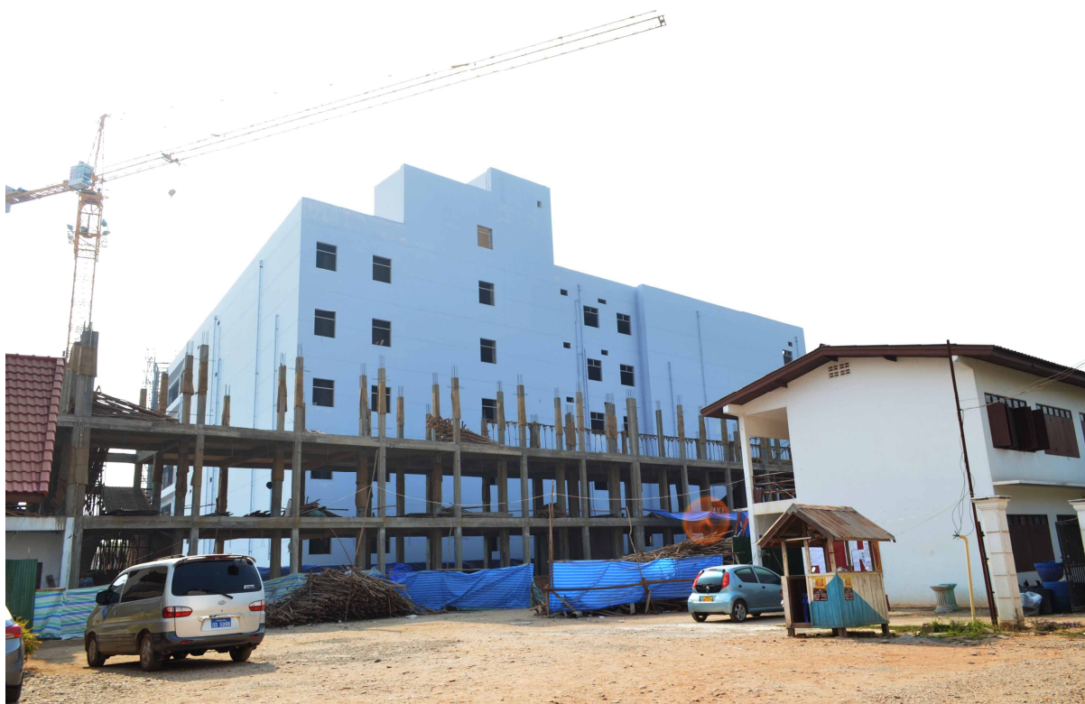
ภาพก่อสร้างอาคารใหม่วิทยาลัยศิลปศึกษา สปป.ลาว
