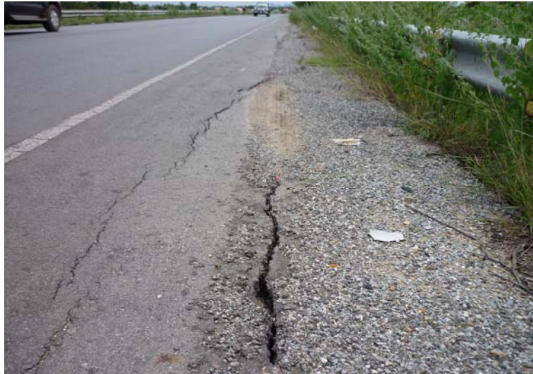
ภาพประกอบ 40 สภาพทางหลวงหมายเลข 2089 (กม.30+000 – กม.33+000)
