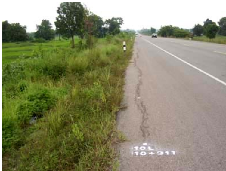
ภาพประกอบ 11 รอยแตกตามขอบ (Edge Crack)
