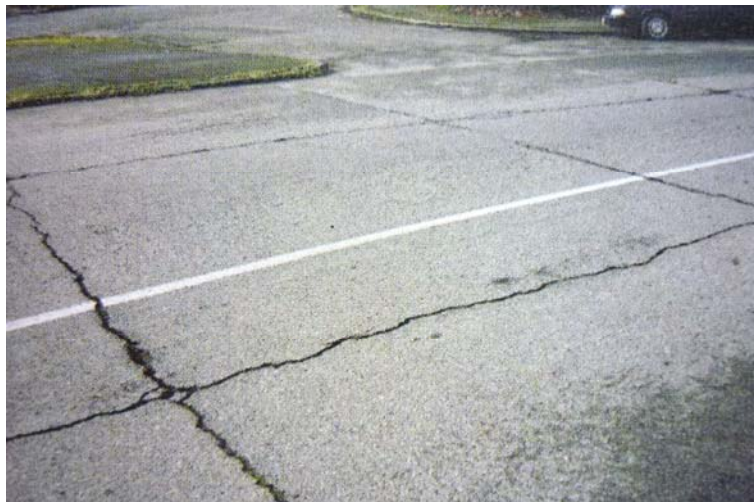
ภาพประกอบ 12 รอยแตกสะท้อน (Reflection Crack)
