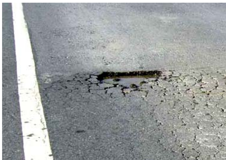
ภาพประกอบ 29 หลุมบ่อ (Pot Hole)
