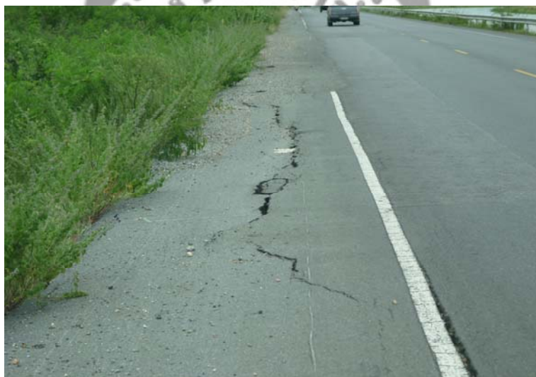
ภาพประกอบ 39 สภาพทางหลวงหมายเลข 2089 (กม.30+000 – กม.33+000)
