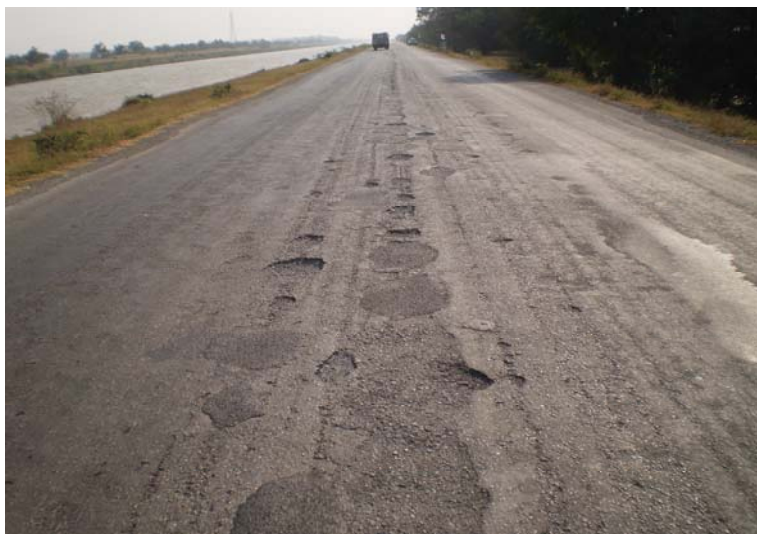
ภาพประกอบ 38 สภาพทางหลวงหมายเลข 3196 (กม.31+000 – กม.42+000)
