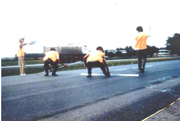
ภาพประกอบ 2 การตรวจสอบสภาพทางกายภาพโดยวิธี Visual Inspection
