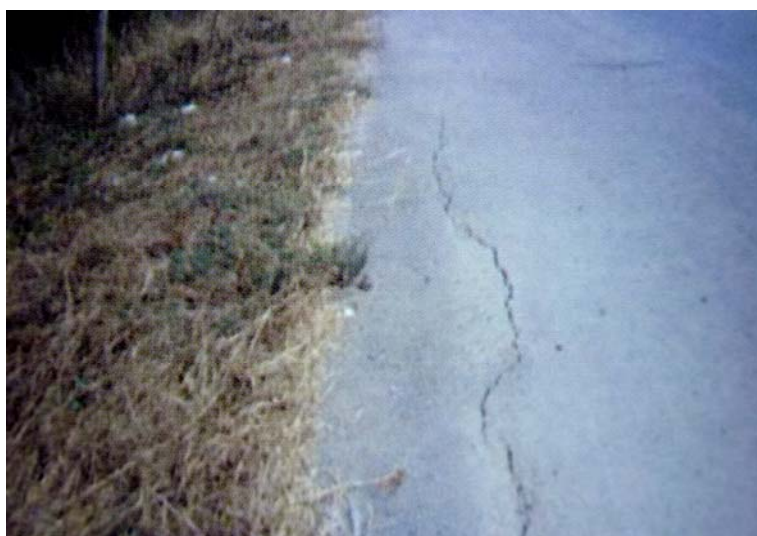
ภาพประกอบ 32 การทรุดตัวต่างระดับของไหล่ทาง (Lane to Shoulder Drop)
