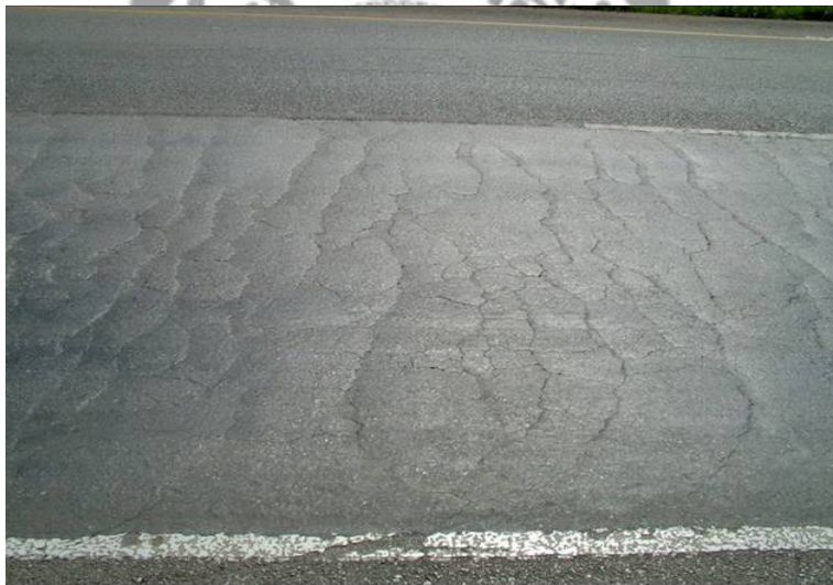
ภาพประกอบ 41 สภาพทางหลวงหมายเลข 3017 (กม.41+000 – กม.44+000)
