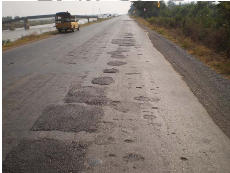
ภาพประกอบ 37 สภาพทางหลวงหมายเลข 3196 (กม.31+000 – กม.42+000)
