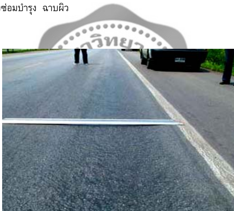
ภาพประกอบ 26 ผิวมวลรวมถูกขัดสีหรือเป็นมัน (Polished Aggregate)
