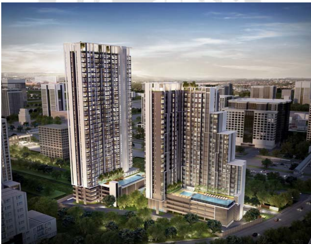
ภาพประกอบ 3 แสดงภาพภายนอก อาคารชุด ควีนส์รีด้า 17
