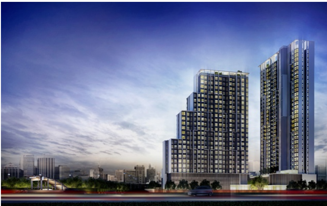
ภาพประกอบ 2 แสดงภาพภายนอก อาคารชุด ควีนส์รีด้า 17
