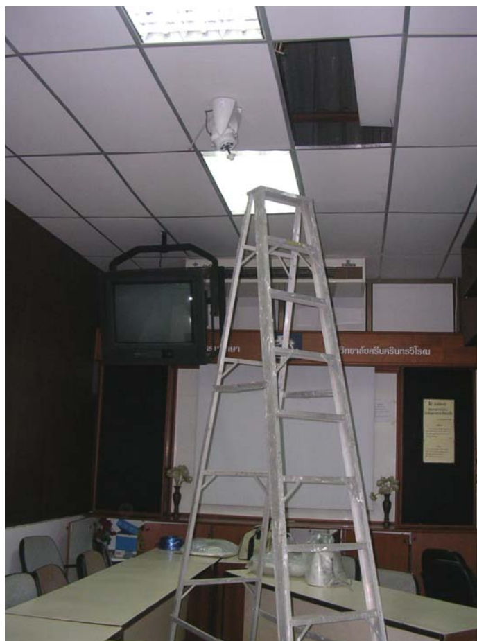
ภาพประกอบ 52 การติดตั้งพัดลมไฟฟ้าแบบโคจร บนฝ้าเพดาน
