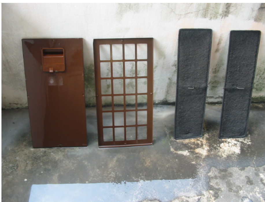
ภาพประกอบ 50 การทำความสะอาดชุดคอนเดนซิ่งยูนิต
