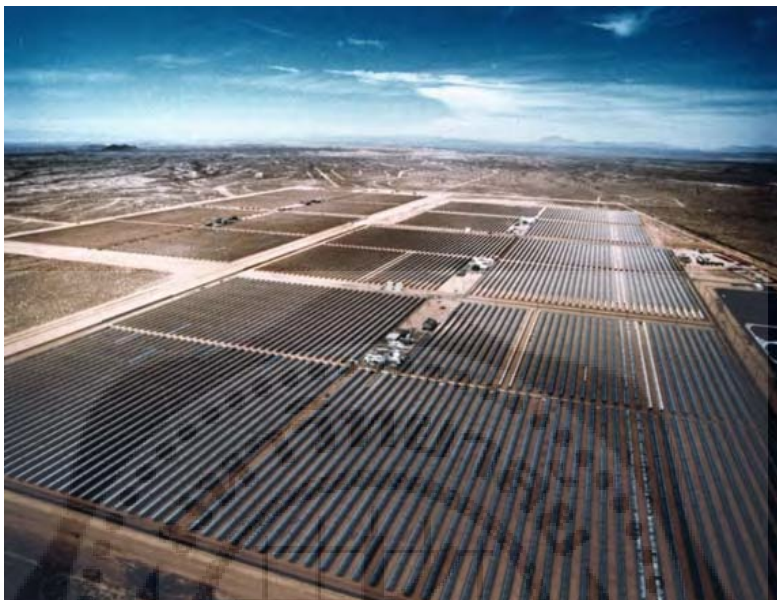
ภาพประกอบ 6 แสดงภาพโรงไฟฟ้า SEGS ที่ Kramer Junction แคลิฟอร์เนีย
