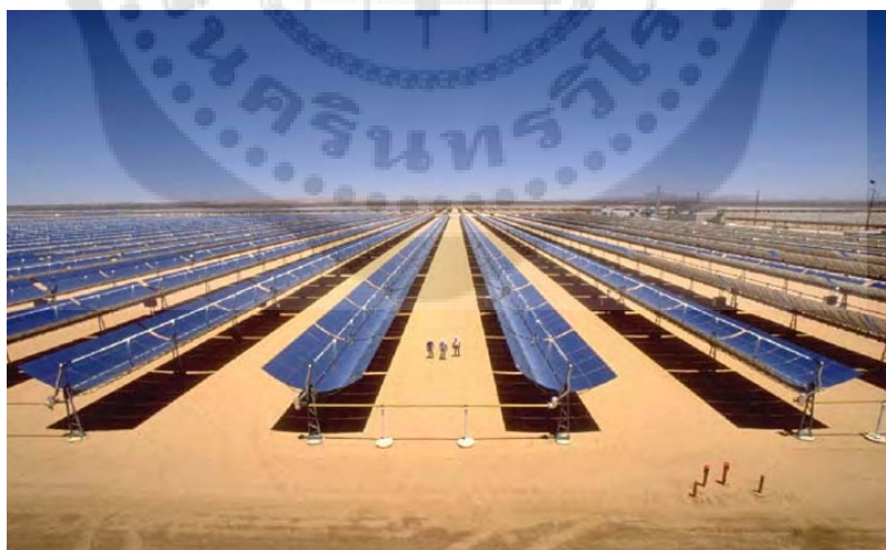
ภาพประกอบ 7 แสดงสนามตัวรับรังสีดวงอาทิตย์ของโรงไฟฟ้า SEGS
