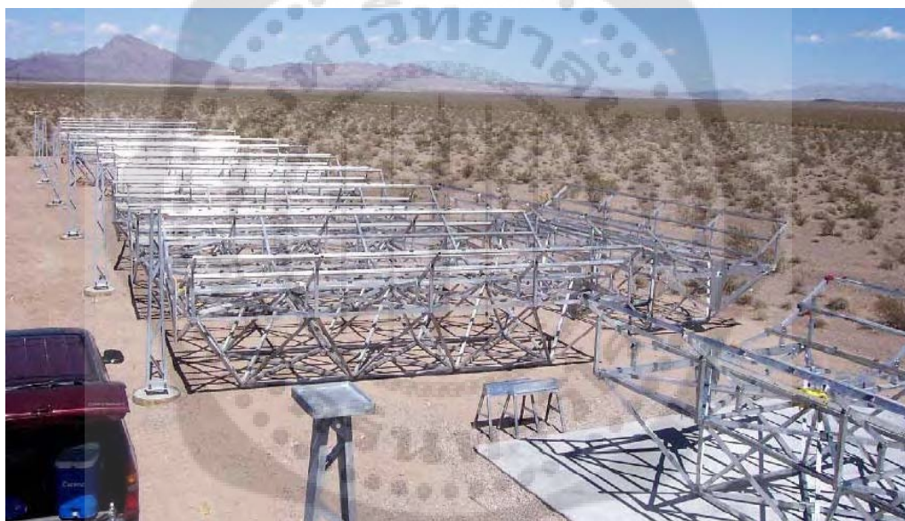
ภาพประกอบ 9 แสดงสนามตัวรับรังสีดวงอาทิตย์แบบรางพาราโบลาของโรงไฟฟ้า Nevada-SEGS อยู่ระหว่างการก่อสร้างที่ Eldorado Valley รัฐเนวาดา
