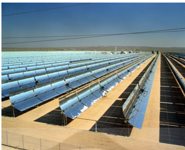
ภาพประกอบ 4 แสดงภาพตัวรับรังสีแบบรางพาราโบลาที่ใช้ในโรงไฟฟ้าพลังงานแสงอาทิตย์เพื่อการชลประทาน Coolidge
