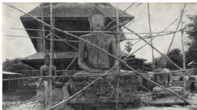
อาคารเรียนโรงเรียนวัดเกาะ “โพธิ์ทองเพิ่มพิทยาคม” อยู่ด้านหลังพระพุทธรูป
