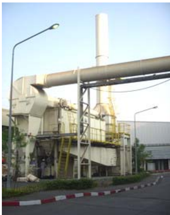
ภาพประกอบ 10 แสดงเครื่องดูดอากาศที่ใช้กับเครื่องทำแบบหล่อ(ซ้าย) และเตาหลอมเหล็ก(ขวา)
