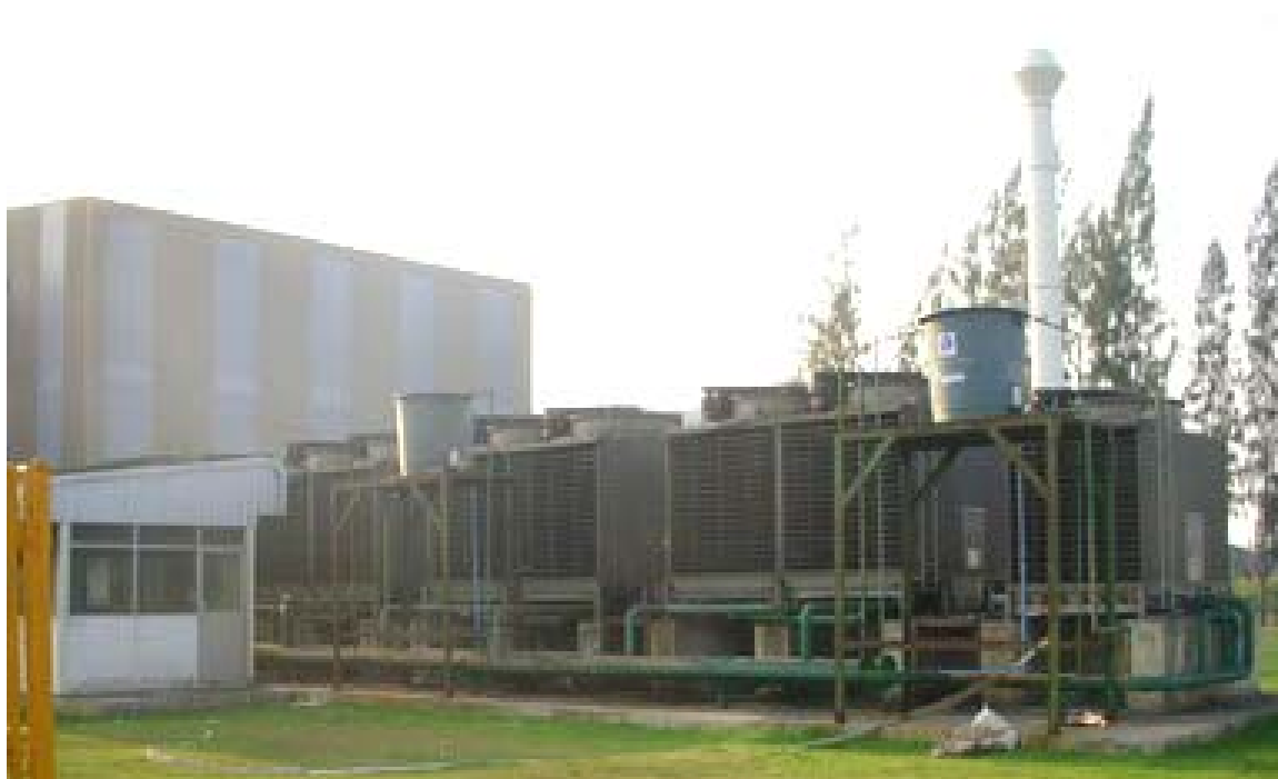
ภาพประกอบ 11 แสดงหอระบายความร้อนที่ใช้ในระบบเตาหลอมโลหะ
