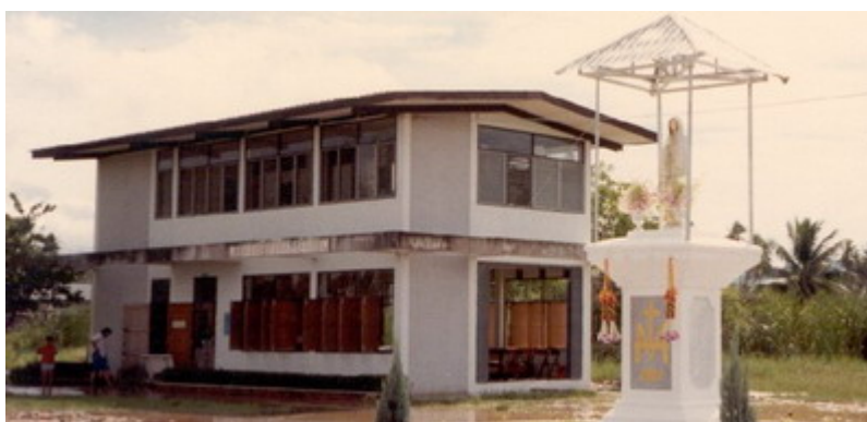
ภาพประกอบ 3 อาคารคอนกรีต 2 ชั้น
