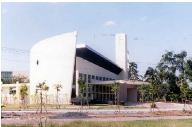
ภาพประกอบ 10 การก่อสร้างการก่อสร้างวัดใหม่เสร็จ (พ.ศ. 2546)
