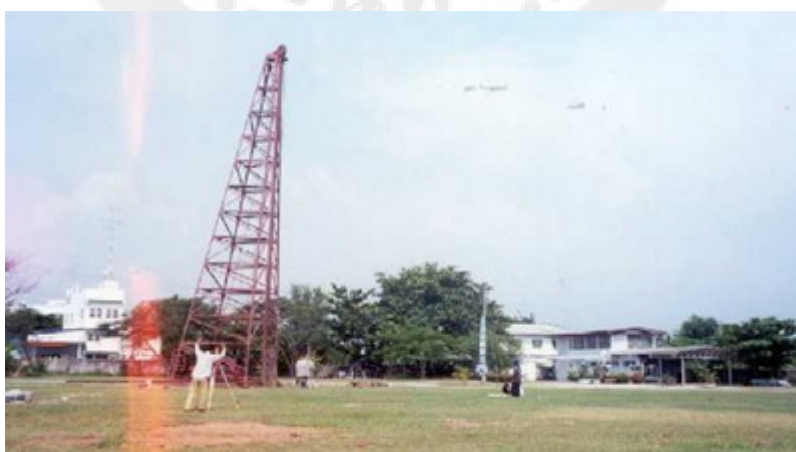
ภาพประกอบ 9 ลงมือตอกเข็มและก่อสร้างวัดใหม่
