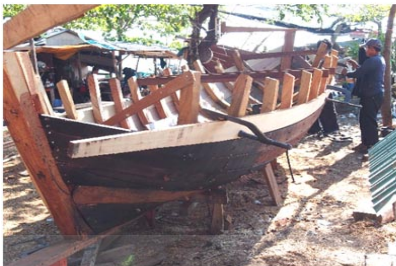
ภาพประกอบ 66 การติดตั้งไม้กระดานข้างเรือของคู่อเรือจังหวัดชลบุรี
