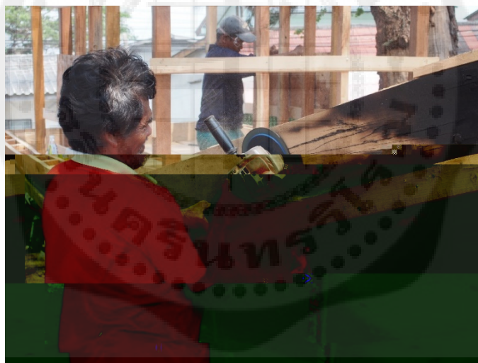
ภาพประกอบ 5 การใช้เครื่องขัดไม้ไฟฟ้า
