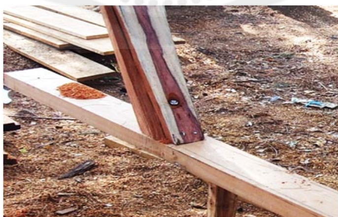
ภาพประกอบ 60 ไชนท่ายเรือติดตั้งเสร็จเรียบร้อยโดยใช้น็อตยึดของคู่อเรือจังหวัดชลบุรี
