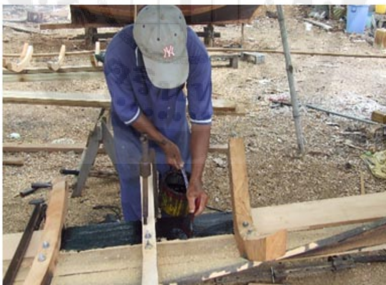
ภาพประกอบ 89 นำน้ำมันเครื่องใช้แล้วทาไม้กระดานก่อนนำไฟมาลนของอู่ต่อเรือในจังหวัดชลบุรี
