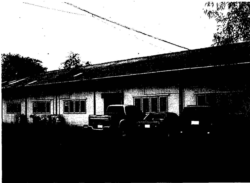
ภาพประกอบ 31 อาคารที่ทำการ โครงการติดตั้งระบบอาณัติสัญญาณไฟสี บังคับสัมพันธ์ ด้วยคอมพิวเตอร์ (Computer Base Interlocking CBI.) บางซื่อ
