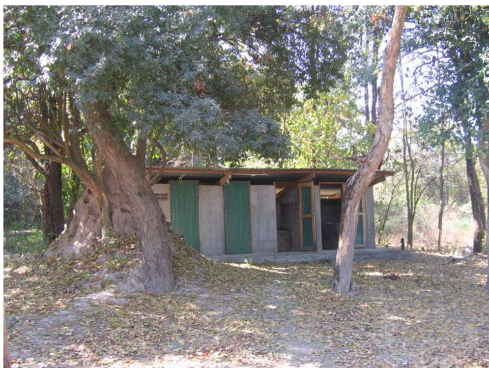
ห้องน้ำสำหรับผู้ให้บริการตลาดนัดโค - กระบือ
