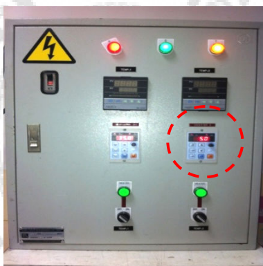
ภาพประกอบ 22 แสดงการเปิดสวิตช์โบลเวอร์และปรับอัตราการไหลของอากาศเริ่มต้น 0.05 \text{ m}^3/\text{s}
