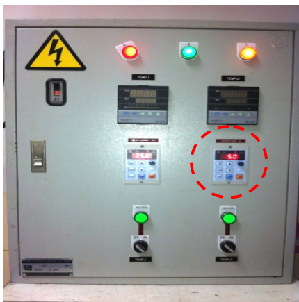
ภาพประกอบ 18 แสดงการเปิดสวิตช์โบลเวอร์และปรับอัตราการไหลของอากาศเริ่มต้น 0.05 \text{ m}^3/\text{s}
