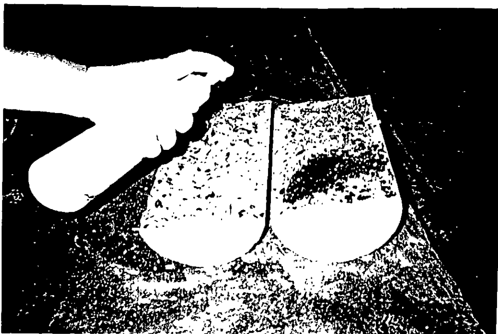
ภาพประกอบ 46 แสดงการทดสอบการทนทานต่อปฏิกิริยาคาร์บอนเนชั่น โดยการฉีดสารละลายฟีนอล์ฟทาไลน์
