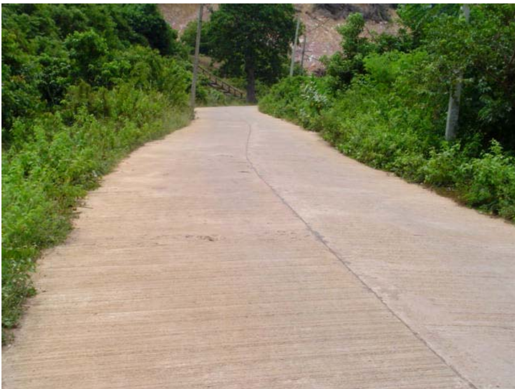
ภาพประกอบ 76 ผิวถนนของโครงข่ายถนนในพื้นที่ศึกษา บริเวณ อ. สิงหนคร จ.สงขลา
