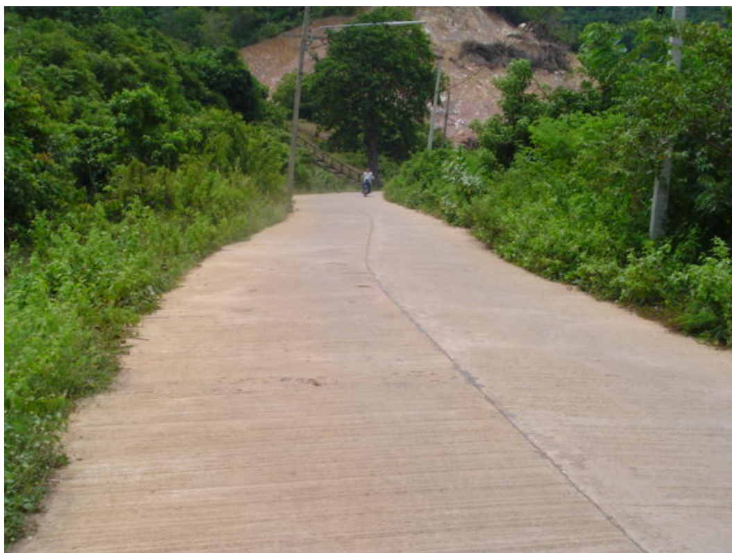
ภาพประกอบ 78 ผิวถนนของโครงข่ายถนนในพื้นที่ศึกษา บริเวณ อ. สิงหนคร จ.สงขลา
