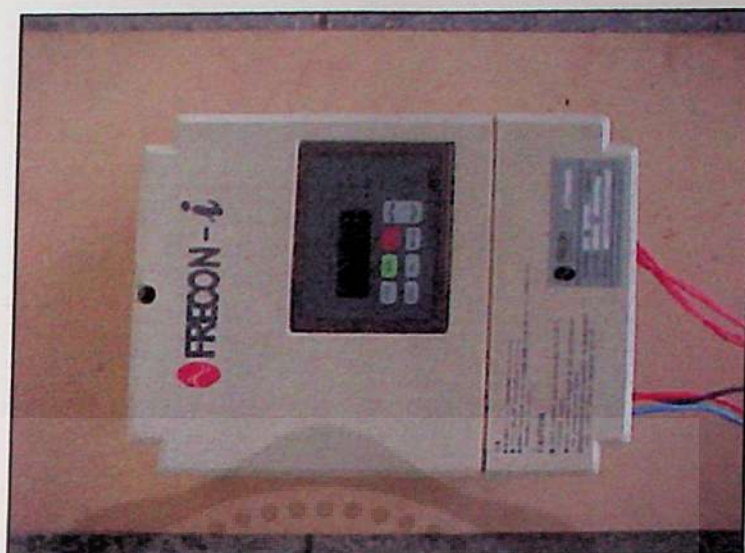
รูปภาพผนวกที่ 2.3 แสดงอุปกรณ์ปรับความเร็วรอบมอเตอร์
