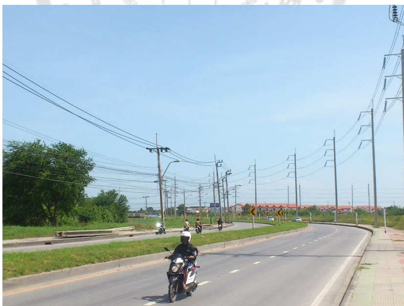
ภาพประกอบ 16 ถนนสายหลักของนิคมฯบางพลี ฝั่งทิศใต้
