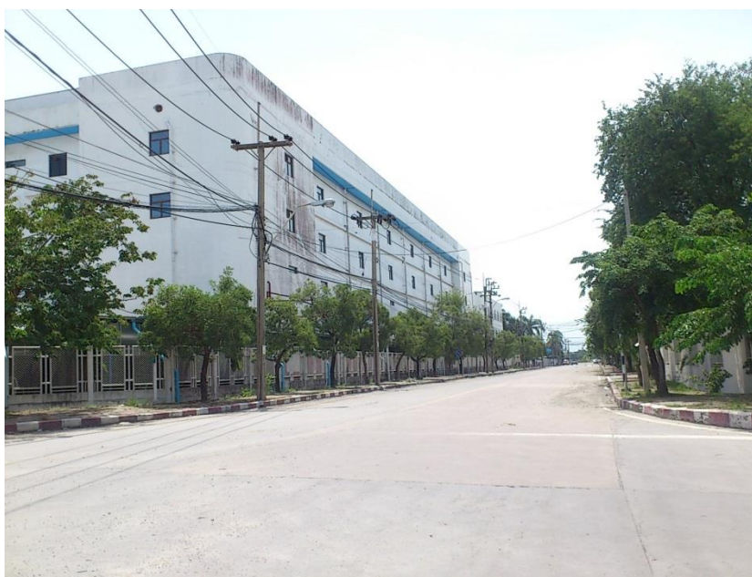
ภาพประกอบ 17 ถนนสายย่อยในนิคมฯบางพลี
