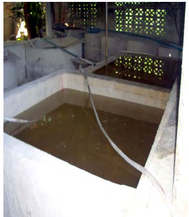
ภาพที่ 40 บ่อที่ใช้สำหรับหมักปูนในปัจจุบันที่ จ. เพชรบุรี
