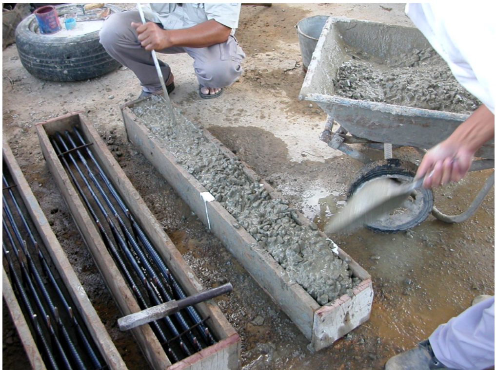
ภาพแสดงการเทคอนกรีตสำหรับใช้เป็นมวลคอนกรีตทดสอบแบบเสริมเหล็ก
