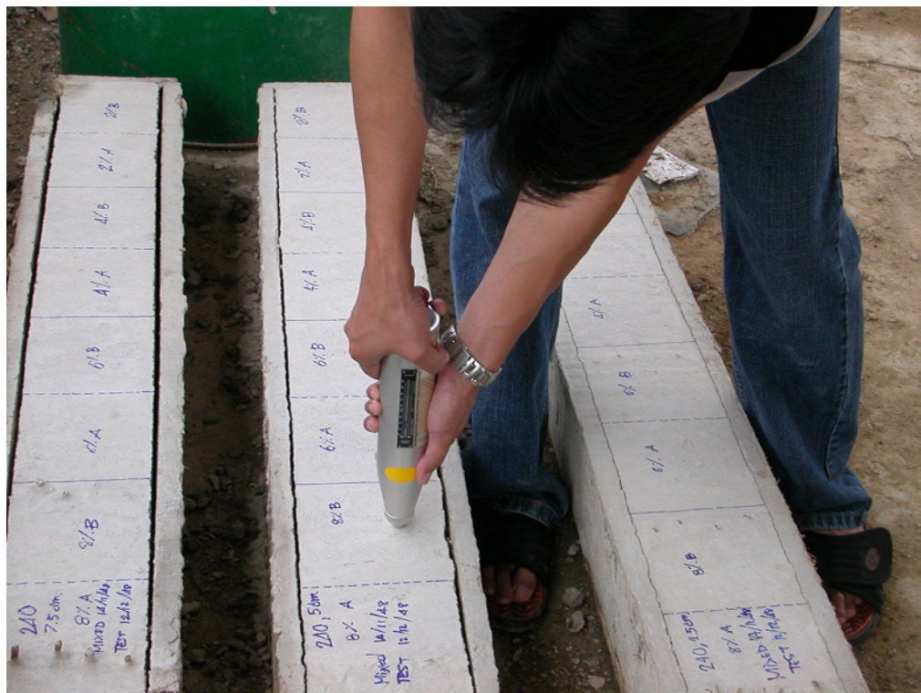
ภาพแสดงการกด Concrete Test Hammer บนมวลคอนกรีตเสริมเหล็ก
