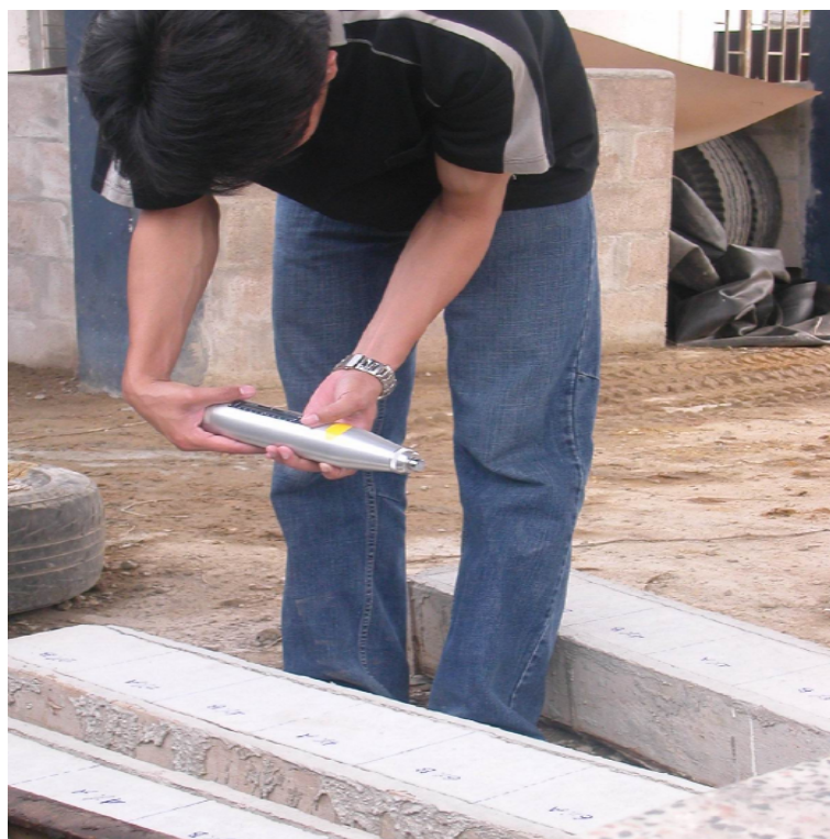
ภาพแสดงการอ่านผลจาก Concrete Test Hammer
