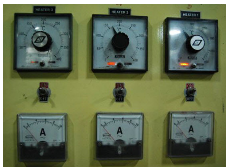
ภาพประกอบ 48 ชุดปรับความร้อนแผ่นความร้อนบริเวณกระบอกลและมาตรวัดอุณหภูมิแผ่นความร้อน
