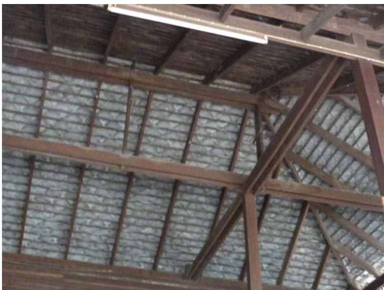
โครงสร้างภายในหลังคาเรือนปั้นหยา
