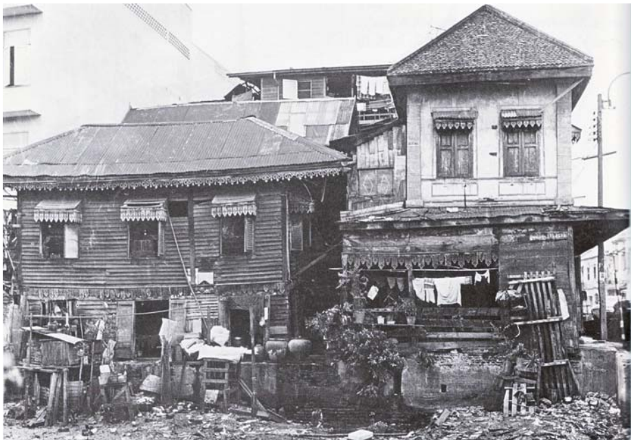
บ้านแบบขนมปังขิง ริมคลองโอ่งอ่าง เชิงสะพานตรงไปเสาชิงช้าการตีฝ่าไม้เป็นเส้นนอน น่าจะนำมาซ่อมสมัยหลัง เดิมอาจจะมาแต่สมัยรัชกาลที่ 5 แล้ว
