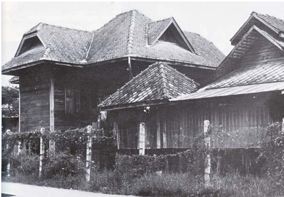
บ้านเรือนทางชลบุรี มีทั้งหลังคาปั้นหยา ที่ไม่มีหน้าจั่วและทั้งแบบหน้าจั่วหลังคาซ้อนกันสองชั้น และแบบเรือนมะนิลา หน้าจั่วตัดปลาย ผสมปนเปกันอย่างอิสระ
