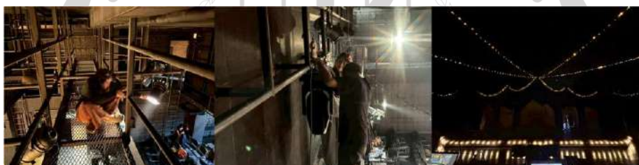
ภาพที่ 3.211 : ภาพการติดตั้งอุปกรณ์ไฟและเทคนิคพิเศษ
