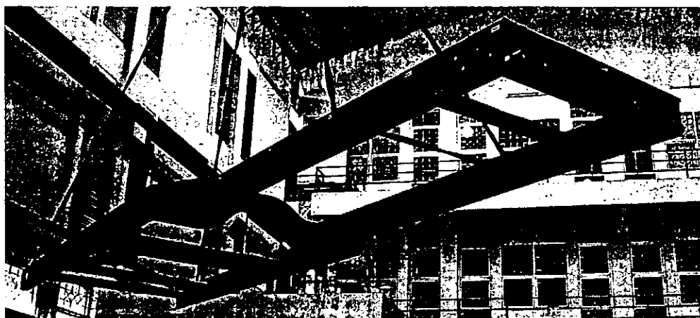
ภาพประกอบ 41 การติดตั้งโครงรถโดยวิธีการแขวนลอยเหนือพื้น
