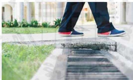
ภาพที่ 27 พื้นทางเดินคอนกรีต
