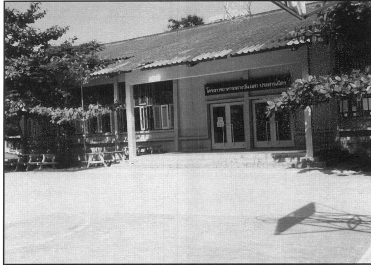
อาคารโรงอาหาร (เดิม) ก่อนก่อสร้างเป็นอาคาร 14
