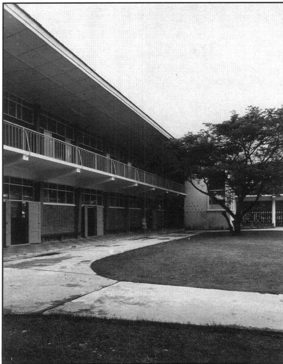
อาคาร 4 หลังเก่า และพื้นที่ส่วนกลางอาคาร
