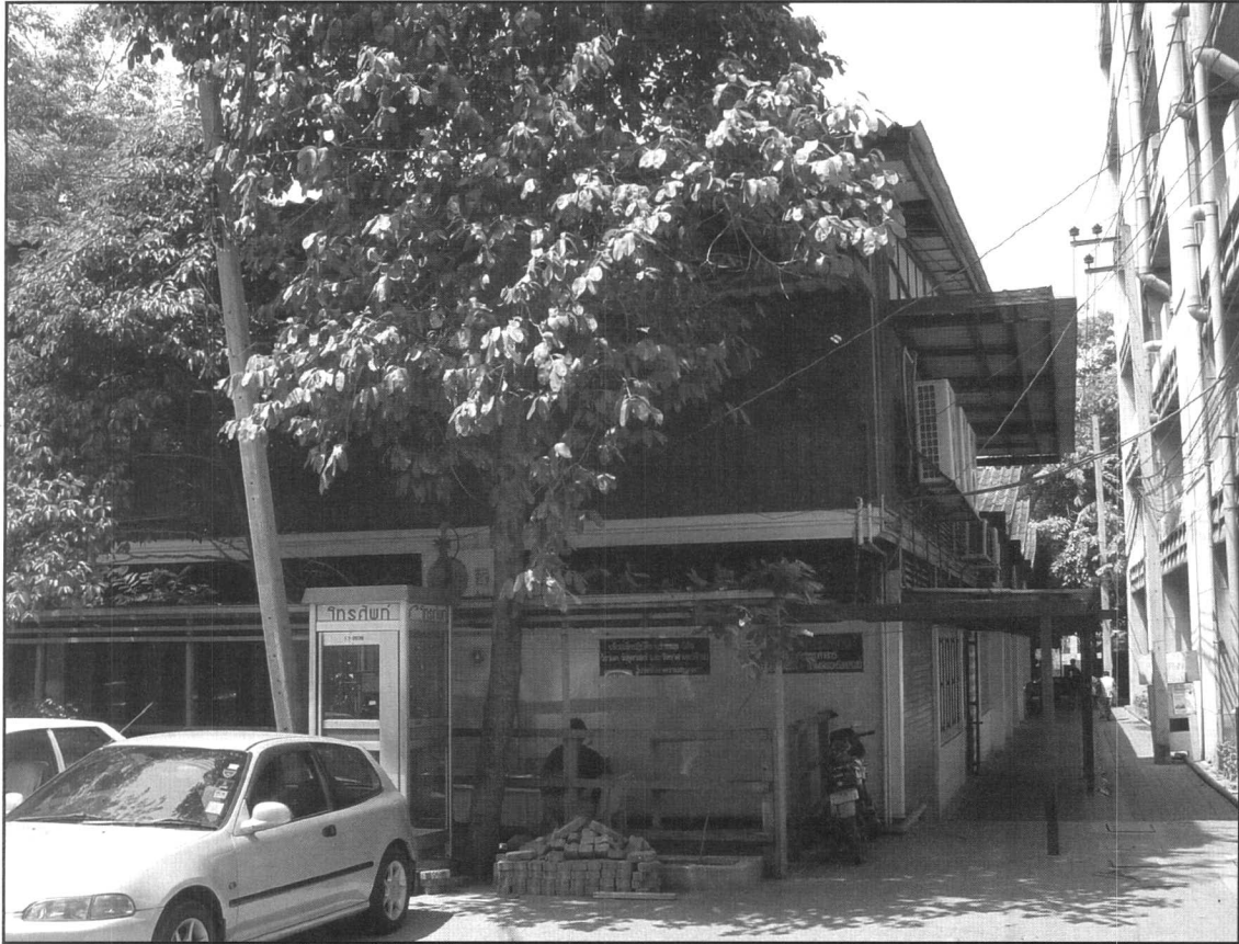
อาคาร 5 โรงฝึกงาน
