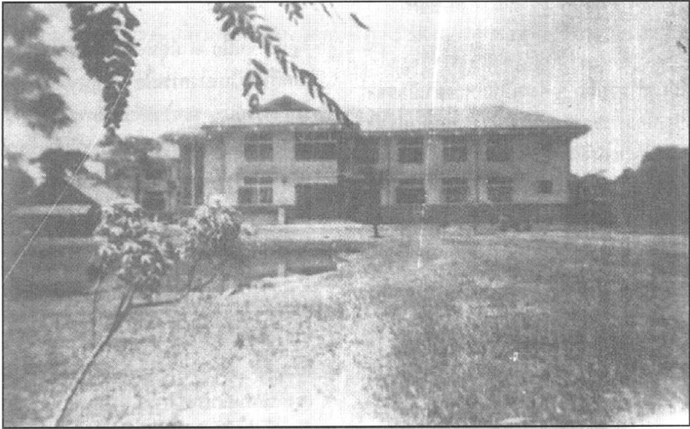
อาคาร 1 หลังเก่า รื้อทิ้งไปแล้ว
