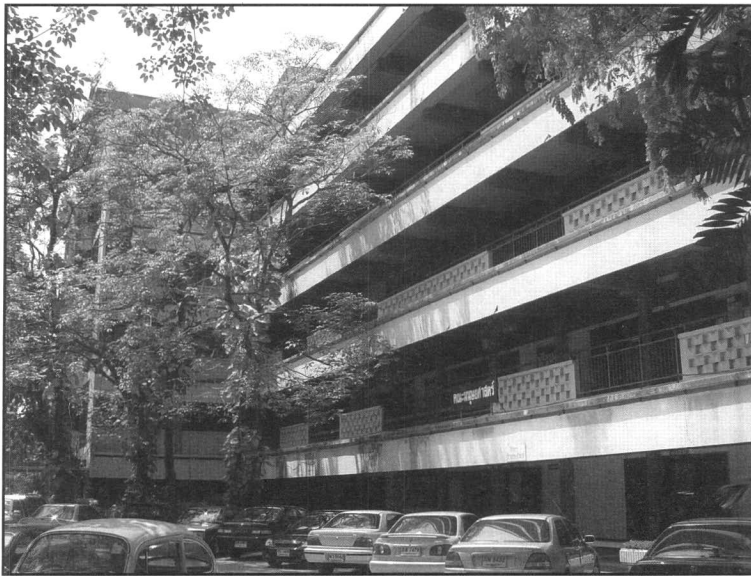
อาคาร 2 ในปัจจุบัน
