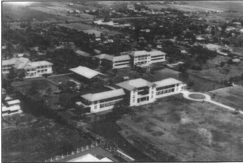
วิทยาลัยวิชาการศึกษา เมื่อ พ.ศ. 2496 ซ้ายสุด หอนอน 1 ขวาสุด หอนอน 2 ด้านหน้า ตึก 3 อาคารเรียนรวม หลังอาคารเรียนคือโรงอาหาร
