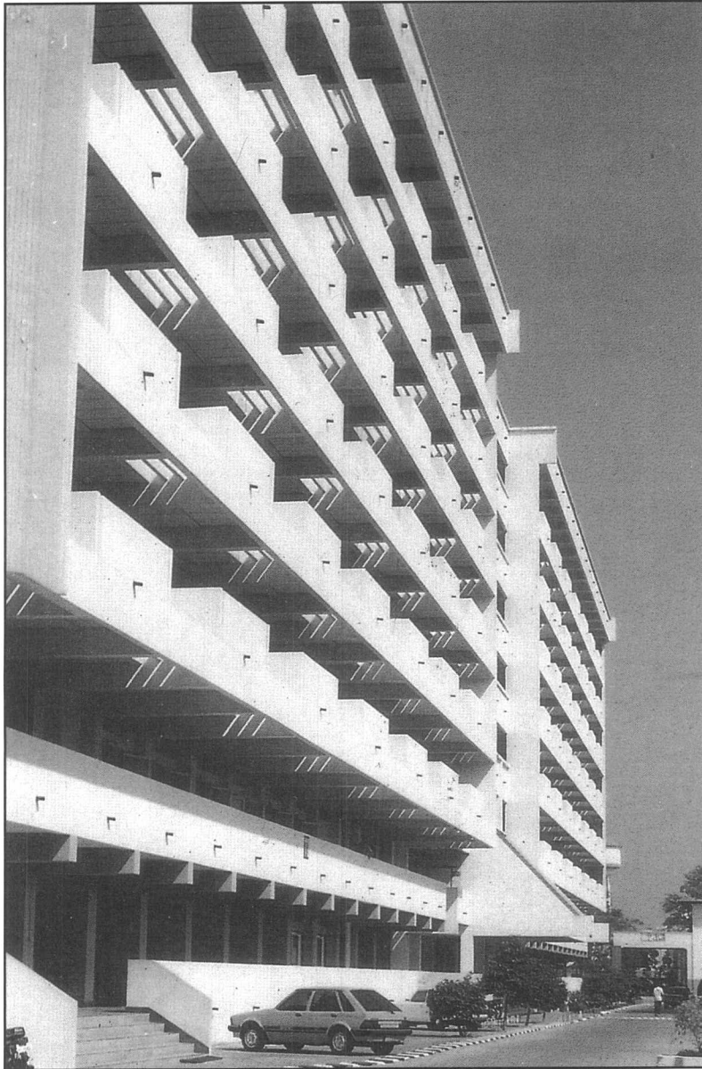
อาคาร 11 และอาคาร 12
