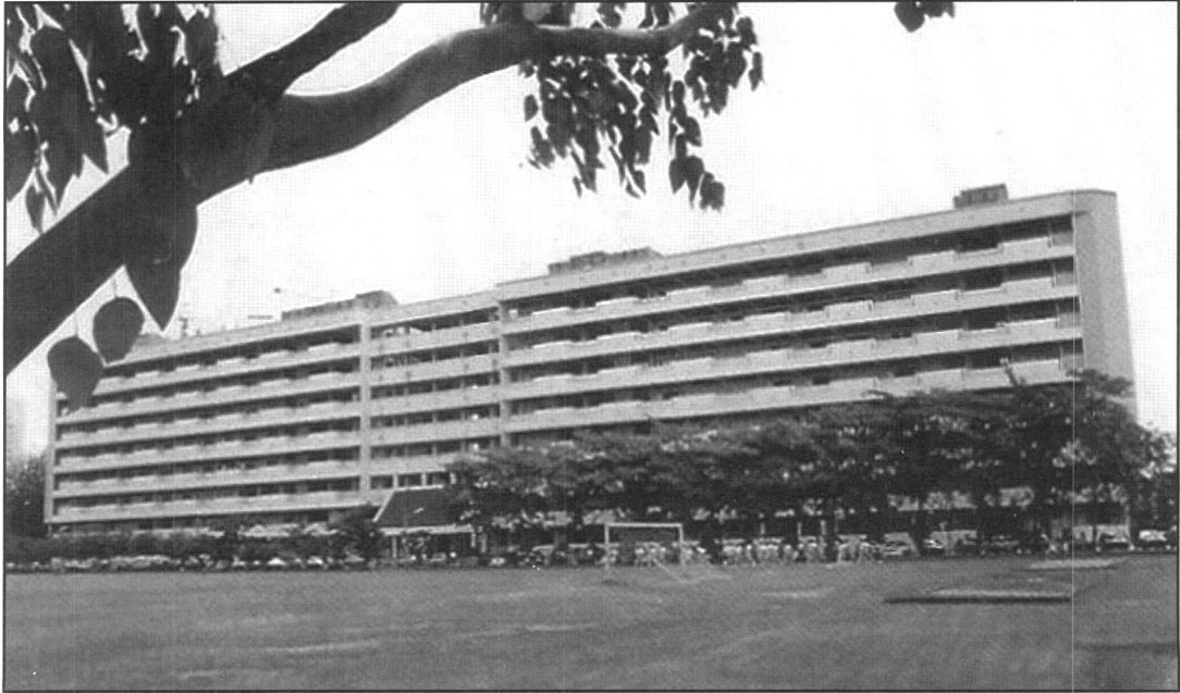
อาคาร 11 และอาคาร 12
