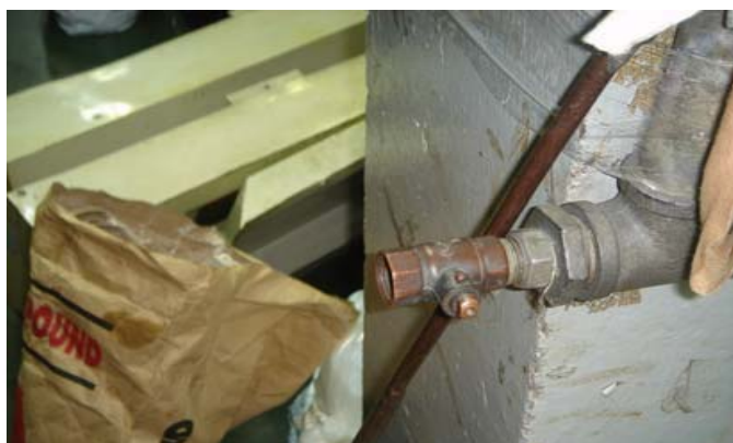
ภาพแสดงจุดที่เกิดการรั่วไหลของอากาศอัด
