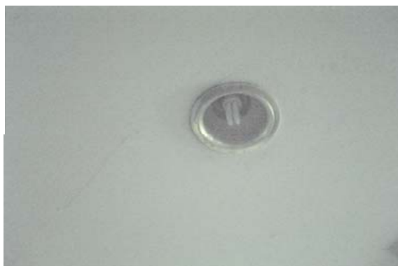
ภาพหลังปรับปรุงใช้หลอดคอมแพกซ์ฟลูออเรสเซนต์แทน
