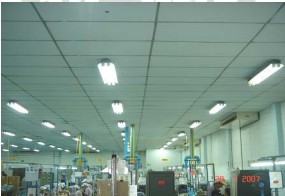
ภาพการติดตั้งและลักษณะของโคมไฟฟ้ายูวามีสวีทซ์
