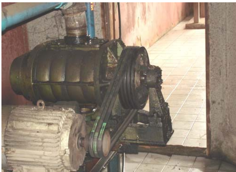
ภาพสภาพหลังการปรับปรุงสายพานที่ชุดมอเตอร์กำลัง
