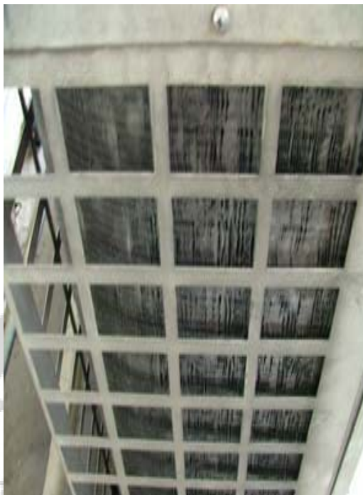
ภาพก่อนทำการปรับปรุงเครื่องปรับอากาศ
