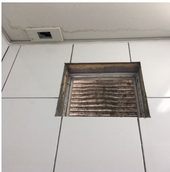
รูปที่ 4.23 ห้องน้ำชายที่ไม่ได้ติดตั้งพัดลมระบายอากาศ
