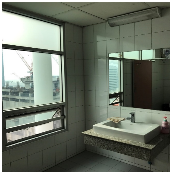
รูปที่ 4.21 ช่องระบายอากาศภายในห้องน้ำของอาคาร
