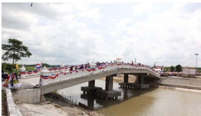
รูปที่ 2.6 สะพานทั่วไปซึ่งเป็นสะพานข้ามแม่น้ำระยอง ณ วัดละหารไร่ จังหวัดระยอง ที่มา: http://thainews.prd.go.thwebsite_thnewsprint_newsTNSOC5806140010065 .
