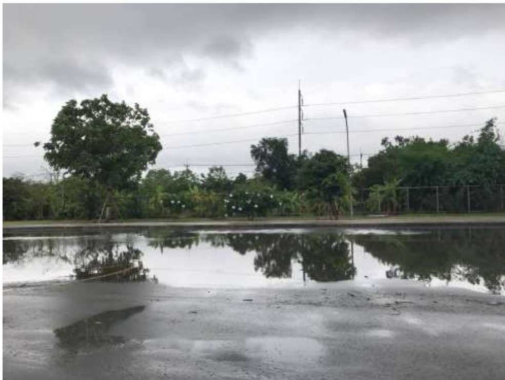
รูปที่ 4.27 บริเวณที่เกิดน้ำท่วมขังบนถนน
