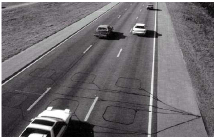
รูปที่ 2.11 เครื่องตรวจจับแบบคลื่นแม่เหล็ก (Magnetic loop detector)
