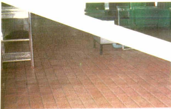
ปรับปรุงพื้นที่อาคารคหกรรม
