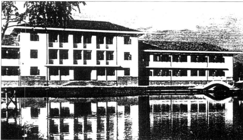
ตึก 2 ตึกโรงเรียนฝึกหัดครูชั้นสูง ที่ถนนประสานมิตร
