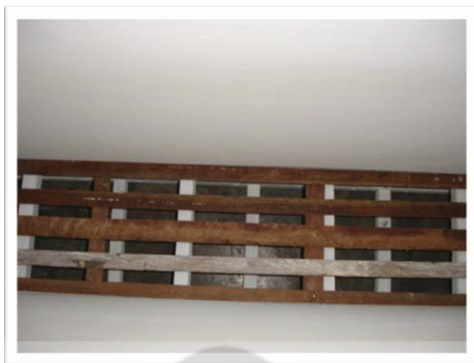
ภาพประกอบ 78 ด้านในของพื้นกันโลง เป็นระแนงไม้ สำหรับวางศพ ทำเป็นพื้นตารางห่างๆ เพื่อให้อากาศถ่ายเทได้สะดวก
