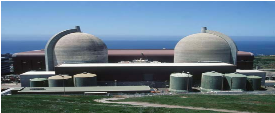
โรงไฟฟ้าพลังนิวเคลียร์
