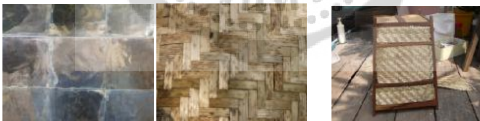
พื้นผิวหลังคา ผนังไม้ไผ่สาน โครงสร้างไม้ไผ่
