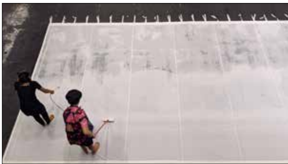
ภาพที่ 1 การอัดน้ำยาให้กับผ้าและแนวตะเข็บของการต่อผ้า ที่มา : ภาพถ่ายโดยผู้วิจัย วันที่ 9 ตุลาคม 2563
