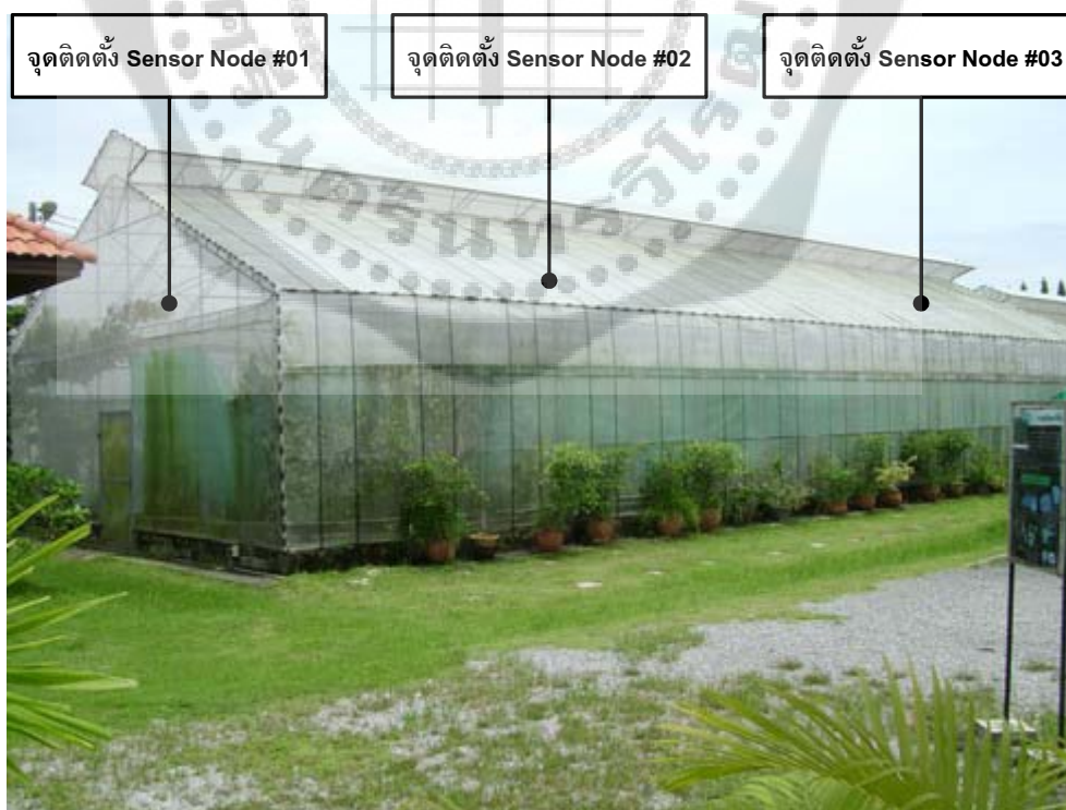
รูปที่ 5.4 โรงเรือนทดสอบและตำแหน่งติดตั้ง Sensor Node
