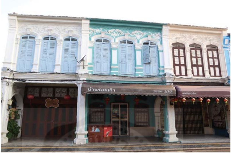
ภาพกลุ่มอาคารบริเวณถนนกลาง ชั้นบนยังคงอนุรักษ์ซุ้มหน้าต่าง บานหน้าต่างบานเกล็ดไม้ และลวดลายปูนปั้น ถนนกลาง อำเภอเมือง จังหวัดภูเก็ต
