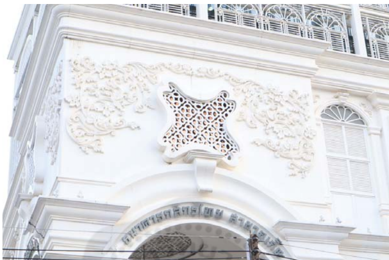
ภาพการทำลวดลายช่องแสงไว้บริเวณภายนอกเลียนแบบอาคารตามแบบบ้านของชาวจีน ธนาคารกสิกรไทย สาขาภูเก็ต ถนนพังงา อำเภอเมือง จังหวัดภูเก็ต
