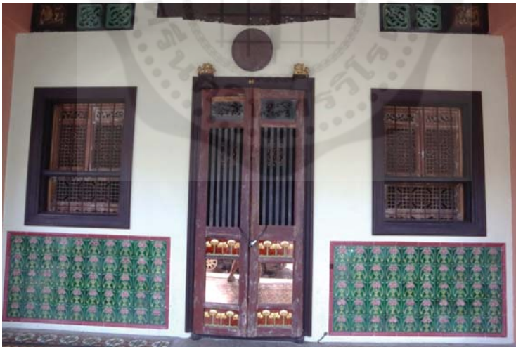
ภาพอาคารที่ใช้โครงสร้างเดิมเป็นสถาปัตยกรรมแบบจีน แต่เปลี่ยนวัสดุและรูปแบบของลวดลาย ถนนถลาง อำเภอเมือง จังหวัดภูเก็ต
