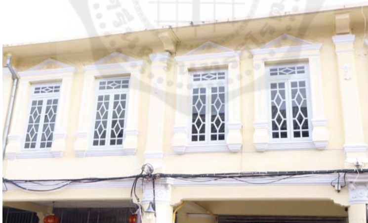
ซุ้มแบบสี่เหลี่ยมด้านบนเป็นรูปจั่วตามสถาปัตยกรรมแบบตะวันตก อาคารย่านถนนกลาง อำเภอเมือง จังหวัดภูเก็ต
