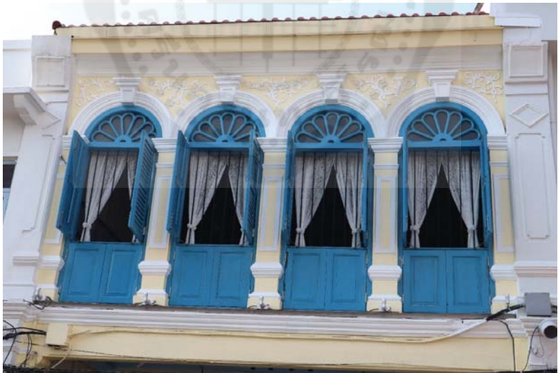
ภาพอาคารบริเวณถนนกลาง ยังคงอนุรักษ์ซุ้มหน้าต่างและลวดลายปูนปั้น แต่หลังคาปรับเปลี่ยน ถนนกลาง อำเภอเมือง จังหวัดภูเก็ต
