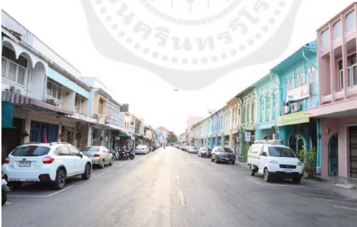
ภาพบ้านเรือนที่สร้างติดกันทั้งสองฝั่งของบริเวณย่านถนนตีบูก ซึ่งคู่ขนานกับถนนกลาง อำเภอเมือง จังหวัดภูเก็ต
