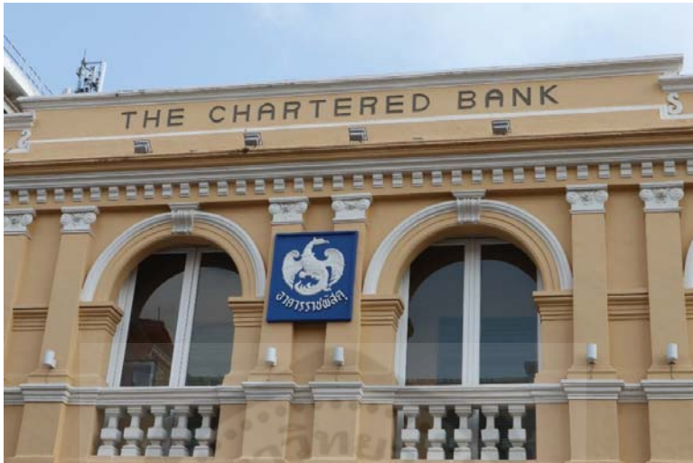
ภาพด้านข้างของอาคารที่จารึกชื่อเดิมว่า The Chartered Bank ถนนพังงา อำเภอเมือง จังหวัดภูเก็ต
