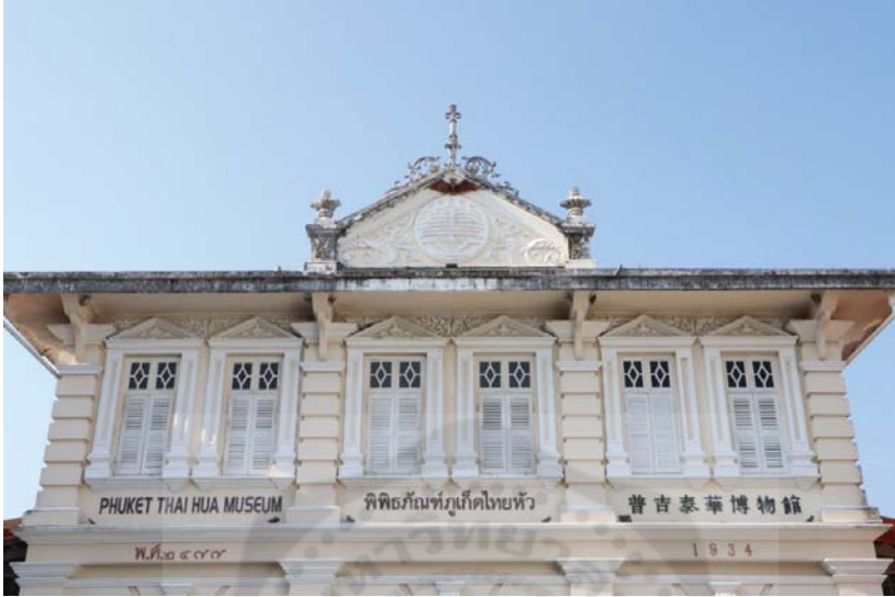
ลักษณะซุ้มหน้าต่างแบบจั่วของพิพิธภัณฑ์ภูเก็ตไทยหัว ถนนกระบี่ อำเภอเมือง จังหวัดภูเก็ต
