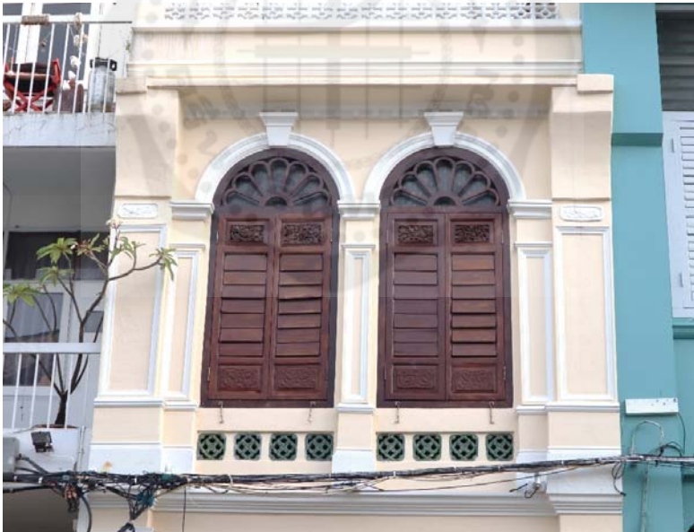
ภาพการซ่อมแซมอาคารโดยเลียนแบบโครงสร้างเดิม มีซุ้มหน้าต่างเป็นโค้งครึ่งวงกลม แต่ไม่มีลวดลายปูนปั้น และหน้าต่างไม้ที่ทำใหม่ ถนนกลาง อำเภอเมือง จังหวัดภูเก็ต
