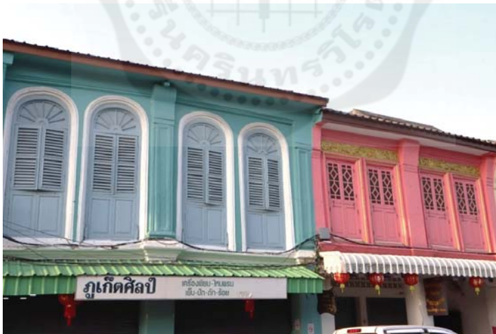
ภาพการทาสีของอาคารต่างๆ และมีการดัดแปลงโครงสร้าง ถนนกลาง อำเภอเมือง จังหวัดภูเก็ต
