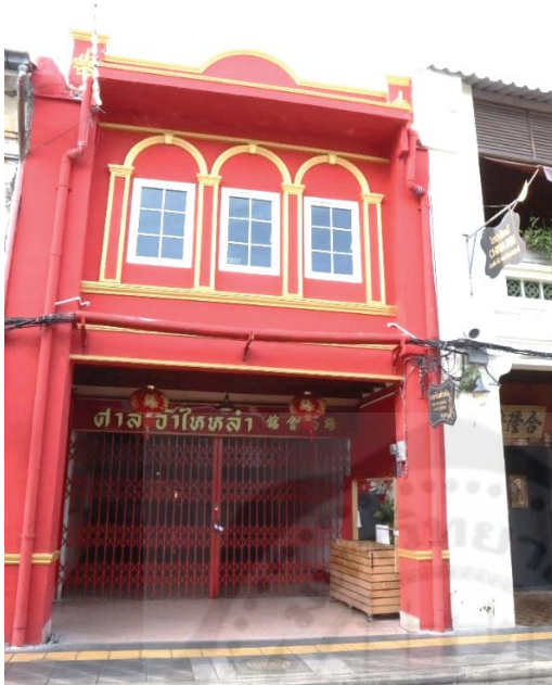
ภาพอาคารศาลเจ้าไททาสีแดงสด มีการปรับเปลี่ยนทั้งบริเวณชั้นบนและชั้นล่าง ถนนกลาง อำเภอเมือง จังหวัดภูเก็ต
