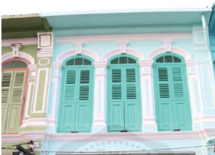
ซุ้มแบบโค้งเสี้ยววงกลมตามสถาปัตยกรรมแบบตะวันตก อาคารย่านถนนตีบุก อำเภอเมือง จังหวัดภูเก็ต
