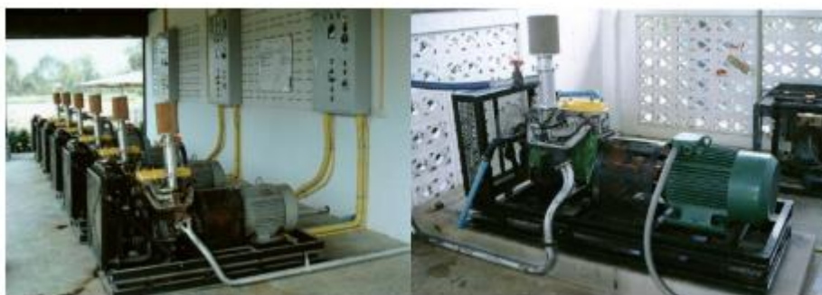
รูปที่ 2.19 เครื่องยนต์เบนซินดัดแปลง (ใช้ก๊าซชีวภาพ 100%)
