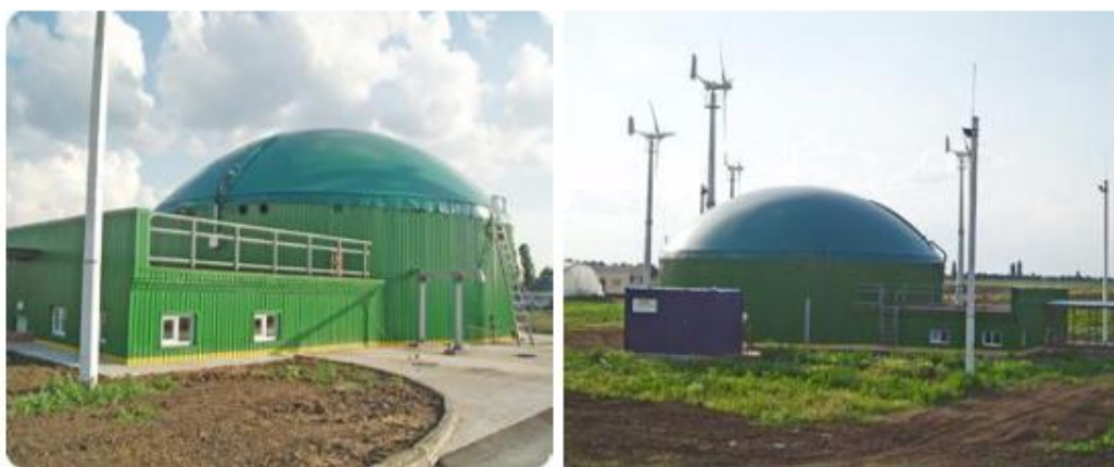
รูปที่ 2.11 ระบบผลิตก๊าซชีวภาพที่ประเทศ UKRAINE, ขนาดระบบ 10 ตัน/วัน (หญ้าเนเปียร์) ขนาดถัง 1,200 ลบ.ม. ผลิตก๊าซชีวภาพ 500 ลบ.ม. ผลิตไฟฟ้า 140 กิโลวัตต์ ปี พ.ศ. 2553
