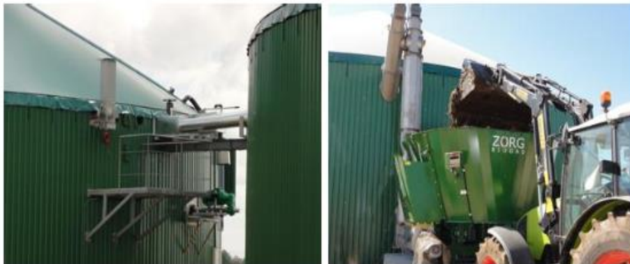
รูปที่ 2.9 ระบบผลิตก๊าซชีวภาพของ Vircava, ประเทศ LATVIA, ขนาดระบบ 30 ตัน/วันขนาดถัง 2400 ลบ.ม. และ 1400 ลบ.ม. ผลิตความร้อนไฟฟ้า(CHP) 560 กิโลวัตต์ ปีพ.ศ. 2554
