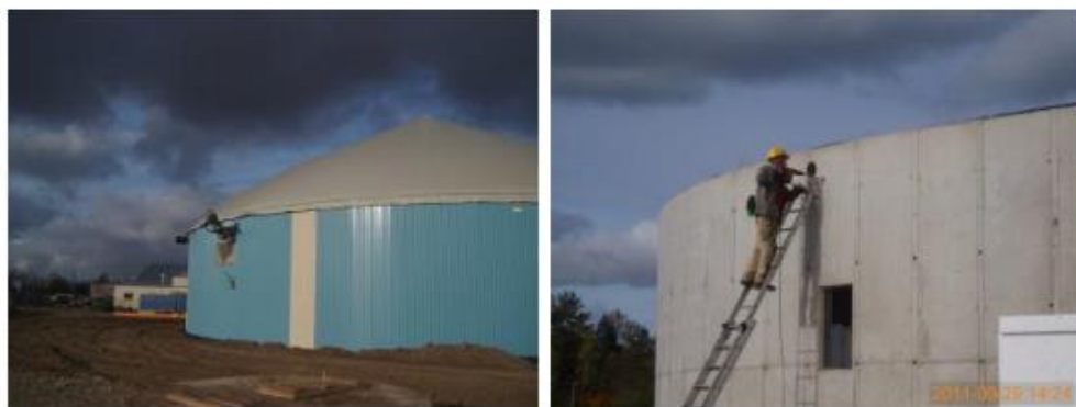
รูปที่ 2.10 ระบบผลิตก๊าซชีวภาพที่ประเทศ LATVIA, ขนาดระบบ 30 ตัน/วัน (เศษข้าวโพด) ขนาดถัง 3,600 ลบ.ม. จำนวน 2 ถัง ผลิตความร้อนไฟฟ้า (CHP) 1,000 กิโลวัตต์ปี พ.ศ. 2554
