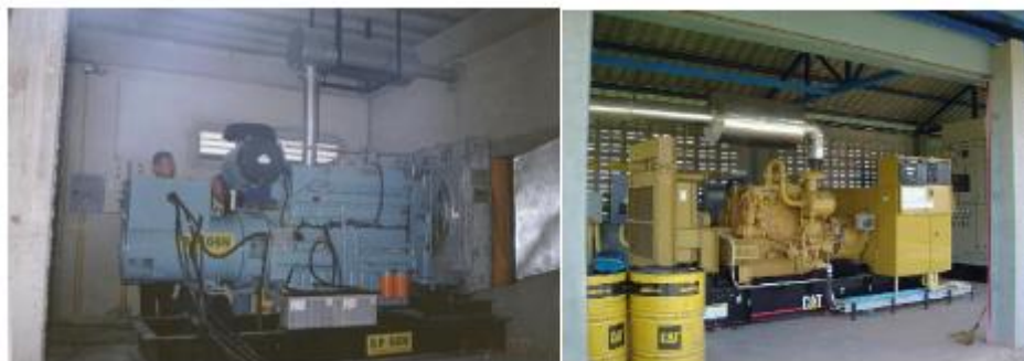
รูปที่ 2.23 เครื่องยนต์ก๊าซชีวภาพ (เครื่องนำเข้า)
