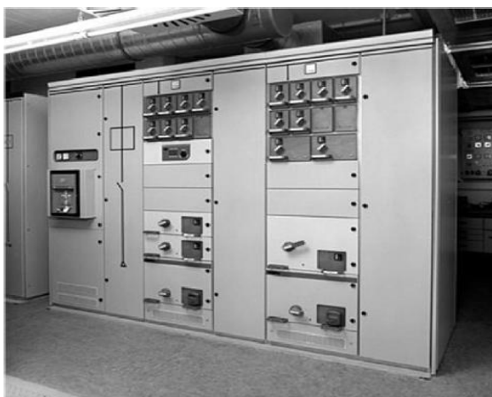
รูปที่ 2.23 ลักษณะภายในและภายนอกของแผงสวิตช์
